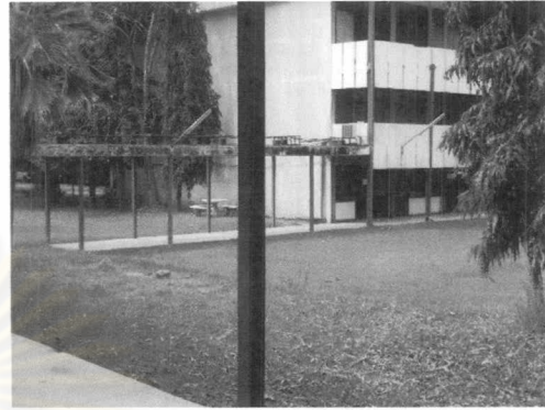
รูปที่ 3.83 ทางเดินเท้ามีหลังคาคลุม(ระหว่างอาคารคณะเกษตรศาสตร์)
