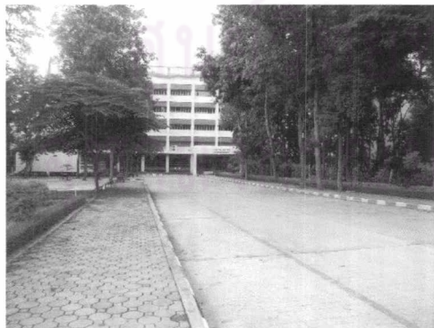
รูปที่ 3.80 ทางเดินเท้าไม่มีหลังคาคลุม (ทางเดินภายในคณะมนุษยศาสตร์)
