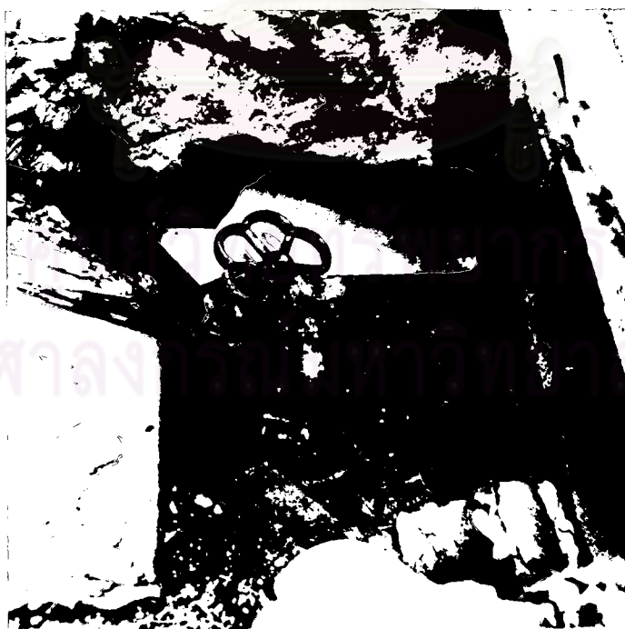
รูปที่ 5-2 วาลวก่อนเข้ามาตรรั่วจนน้ำยังเป็นแอ่ง ผู้ใช้น้ำประเภทโกดัง ที่อยู่ 2108 ถนนเจริญกรุง (เดือนพฤษภาคม พ.ศ.2526)
