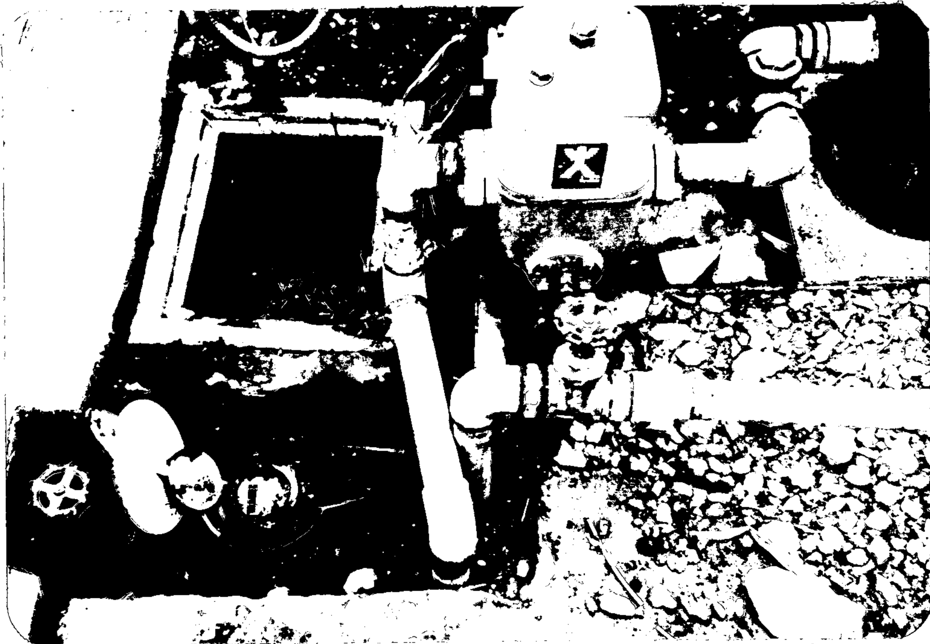
รูปที่ 5-7 มาตรการน้ำขนาด 2 นิ้ว ผังอยู่ใต้พื้นคอนกรีต ผู้ใช้น้ำประเภท โรงงาน เลขที่ 797 ซอยร่มไผ่เงิน ถนนจันทร์ (เดือนเมษายน 2526)
