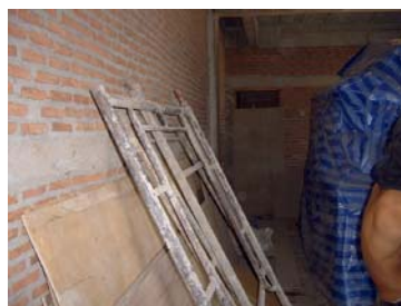
ภายในอาคาร 4 ชั้นที่สร้างใหม่
