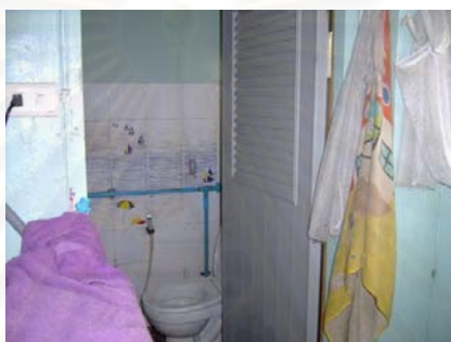
บริเวณภายในบ้านชั้นล่างห้องน้ำทำใหม่
