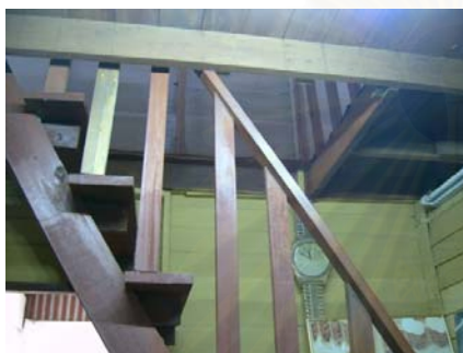
บันไดขึ้นชั้นบน
