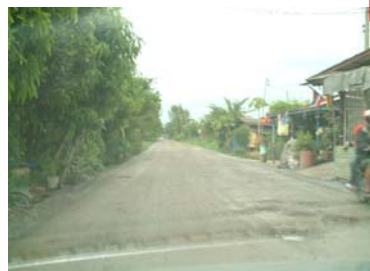
รูปที่ 4.19 สภาพถนนที่ทรุดโทรม เป็นหลุมบ่อ มีขนาดแคบ โดยเฉพาะบริเวณสะพาน ข้ามคลอง
