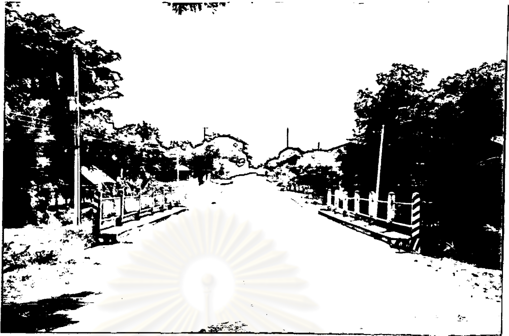
รูปที่ 3.6 แสดงแนวทางพื้นสะพาน ก.ม.9/907 ทางหลวงหมายเลข 10120100
