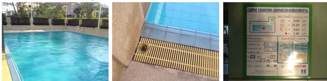
สภาพสระว่ายน้ำโครงการ ลุมพินี คอนโดทาวน์ บดินทร์เดชา-รามคำแหง
