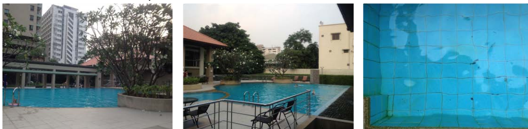
สภาพสระว่ายน้ำโครงการ ลุมพินี เฟลส พหลฯ-สะพานควาย
