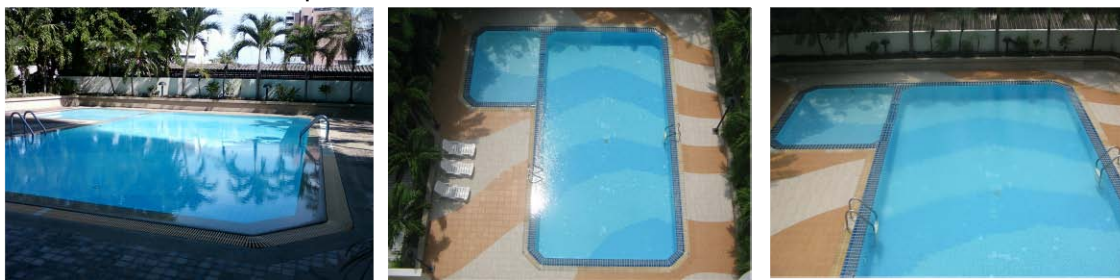
สภาพสระว่ายน้ำโครงการ ลุมพินี เฟลส
