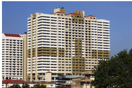
อาคารโครงการ พี.เอส.ที. ซิตี โฮม
