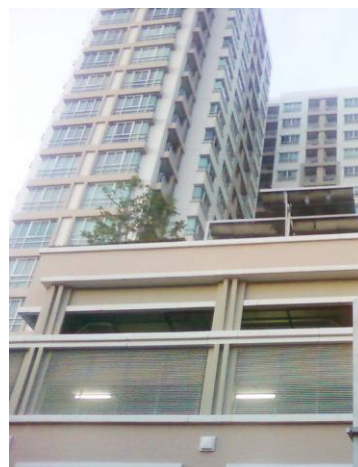
อาคารโครงการ ลุมพินี สวีท ปิ่นเกล้า
