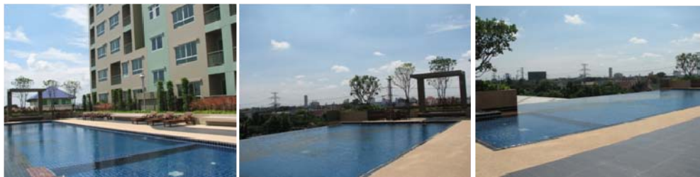
สภาพสระว่ายน้ำโครงการ ลุมพินี วิลลส์ ราษฎร์บูรณะ
