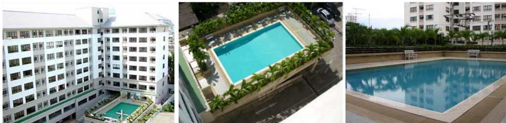
สภาพสระว่ายน้ำโครงการ ลุมพินี วิลลส์ พระแม่มาลี
