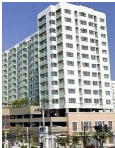
อาคารโครงการ ลุมพินี เฟลส รามอินทรา-หลักสี่
