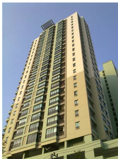
อาคารโครงการ ลุมพินี เฟลส ปิ่นเกล้า 2
