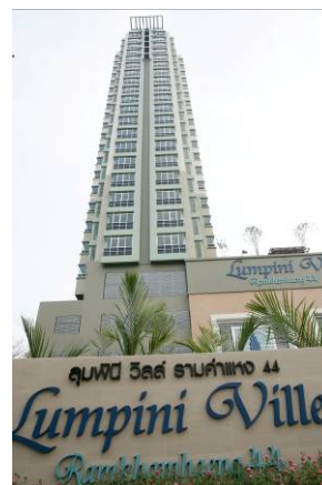
อาคารโครงการ ลุมพินี วิลล์ งามคำแหง 44
