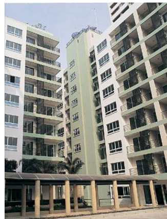
อาคารโครงการ ลุมพินี สวีท สุขุมวิท 41
