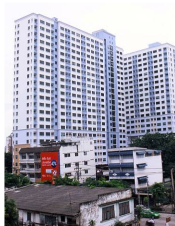
อาคารโครงการ ลุมพินี วิลล์ สุขุมวิท 77
