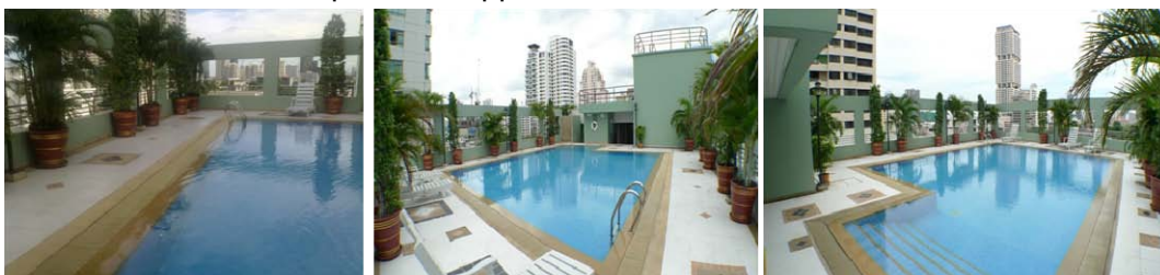
สภาพสระว่ายน้ำโครงการ ลุมพินี สวีท สุขุมวิท 41
