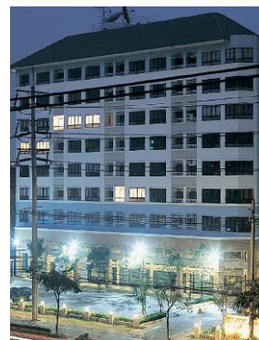
อาคารโครงการ ลุมพินี เฟลส พระราม3 (เจริญกรุง)
