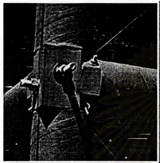
ภาพที่ 2-9 รอยต่อโครงสร้างท่อกะต๊อ
