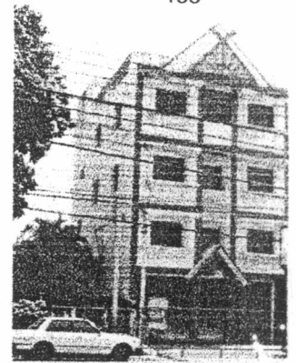
ภาพที่ 4.77 ตึกแถวหลังคาคาคาฟ้า ออกแบบใหม่มีส่วนคานหน้าเป็นรูปทรงจั่วและหล่อคอนกรีตกากบาทคล้ายกาแลเพื่อให้เข้าชายถูกต้องตามข้อกำหนด
