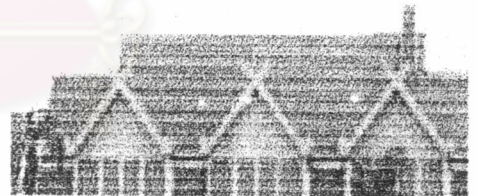
4.47 หลังคาทรงจั่วซ้อนชั้น มีจั่วออกเป็นมุขหน้าของแต่ละห้องแถว ส่วนของบ้านลม กาแลและหางวันเป็นวัสดุหล่อคอนกรีตขนาดใหญ่ คู่ค่อนข้างเทอะทะ ไคร้กระเบื้องซีแพคสีเขียวอ่อนดูสะอาดตา เป็นอาคารกึ่งพาณิชย์และกึ่งอาศัยโครงการใหญ่ที่สร้างมาแล้วขายไม่ออกจึงเป็นอาคารร้างบริเวณด้านแจ้งหัวลิน
