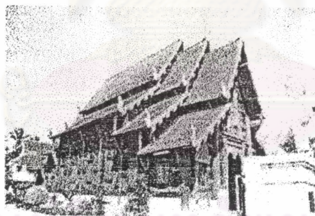
4.32 วัดพันเตา เป็นวัดที่ตั้งอยู่ ณ สี่แยกกลางเวียงติดกับวัดเจดีย์หลวงฯ พระวิหารเป็นอาคารไม้ที่รื้อมาจากหอคำของพระเจ้ากาวิโรสุ เป็นงานสถาปัตยกรรมประเภทคุ้มเจ้านายเชียงใหม่สมัยก่อน ได้รับการขึ้นทะเบียนเป็นโบราณสถานสำคัญของชาติ วิหารหลังนี้มีงานศิลปกรรมที่มีความสวยงามและคุณค่าทางประวัติศาสตร์มาก และถูกบรรดาม้าจาชีพมาลัทธิโขนบ่อยครั้ง บางส่วนจึงเป็นงานที่สร้างเทียบขึ้นมาทดแทนของเดิมเท่านั้น
