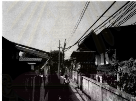
ภาพที่ 4.2.3-3 ระบบไฟฟ้าภายในชุมชนเกาะเกร็ดบริเวณโซน B
