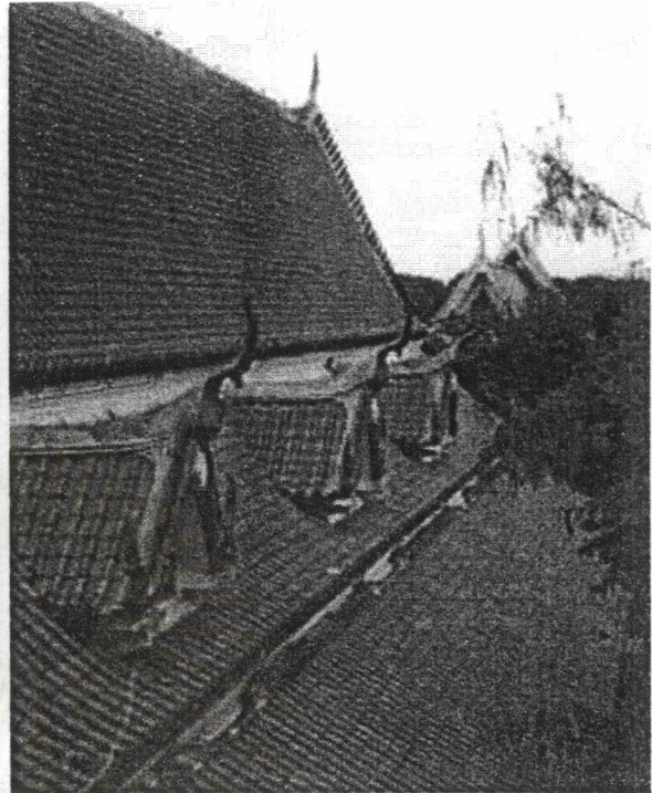
ช่องหลังคาระบายอากาศชั้นใต้หลังคา
