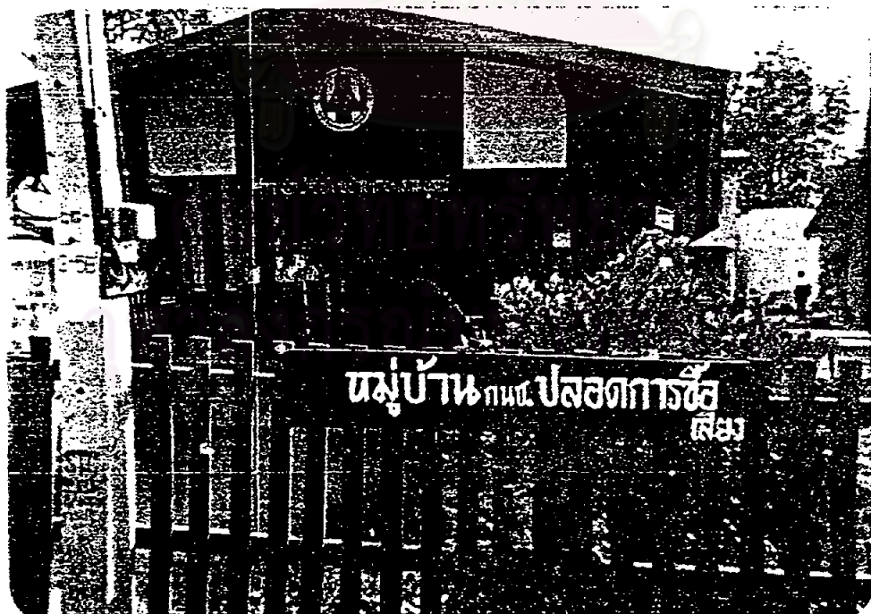
ศาลาประชาธิปไตยบ้านเกษตรสมบูรณ์ ตำบลบ้านสี กิ่งอำเภอบ้านหลวง จังหวัดน่าน ด้านหน้าจะเห็นป้ายหมู่บ้านปลอดการซื้อเสี่ยง เป็นส่วนหนึ่งของ การรณรงค์ตามโครงการเผยแพร่ประชาธิปไตยระดับหมู่บ้าน (พม.) โดย ใช้ศาลาประชาธิปไตยเป็นจุดศูนย์กลางในการดำเนินงาน
