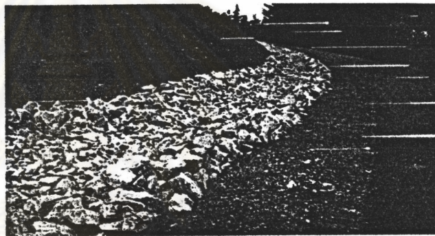
ภาพที่ 5.12. ภาพแสดงตัวอย่างการปูวัสดุสังเคราะห์ที่ซึมผ่านน้ำได้ต่ำในการสร้างรางหิน (Russ, ASLA and REM, 2000: 403)
