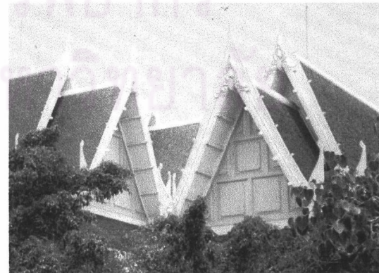
ภาพที่ 3-57 เครื่องปิดหลังคาศาลาการเปรียญวัดนิมมานรดี เครื่องปิดหลังคามีลักษณะคล้ายปั้นลมแบบเรือนไทย แต่ตัวเหงเป็นทางหงส์ทรงนาค
