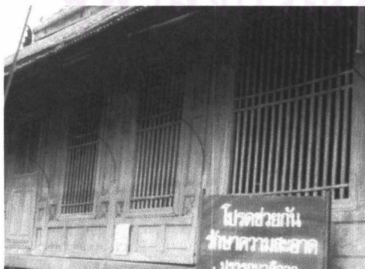
ภาพที่ 3-74 ผนังและช่องเปิดศาลาการเปรียญวัดอัปสรสวรรค์หน้าต่างเป็นลูกกรงไม้ไม่มีบานเปิด ประตูเป็นบานเปิดเข้าด้านใน
