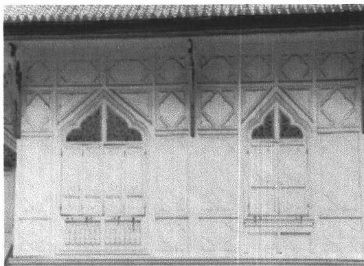
ภาพที่ 3-75 ผนังและช่องเปิดศาลาการเปรียญวัดราชธาภิวาส ประตู และหน้าต่างเป็นบานเปิด และบานเพี้ยม มีช่องระบายอากาศด้านบน
