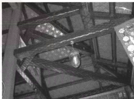
ภาพที่ 3-82 โครงสร้างหลังคาสถาปัตยกรรมเบรียวัดเทพธิดาราม ทำลายฉลุปิดทองในส่วนโครงสร้างหลังคาที่เป็นไม้
