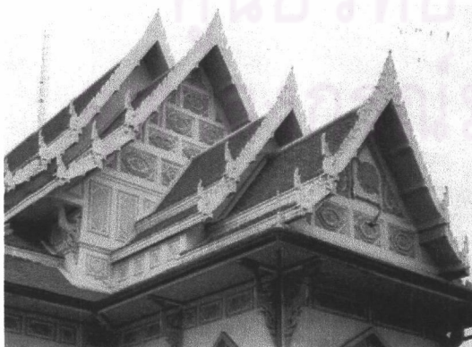
ภาพที่ 3-56 เครื่องปิดหลังคาศาลาการเปรียญวัดอินทรวินัย เครื่องล่ายช่อฟ้าแบบรวรจอม ไบระกาปูนปั้นแบบทยอยจับหลัก ตัวเหงเป็นทางหงส์ทรงนาค
