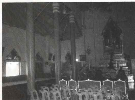
ภาพที่ 3-49 ระบบโครงสร้างศาลาการเปรียญวัดอินทวิหาร โครงสร้างหลังคาคอนกรีตเสริมเหล็กทำให้ฝ้าเพดานโล่งไม่มีคานขวาง
