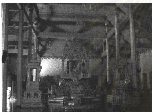
ภาพที่ 3-48 ระบบโครงสร้างศาลาการเปรียญวัดปากน้ำ โครงสร้างหลังคาคอนกรีตเสริมเหล็กทำเลียนแบบไม้แต่วางคานตามแนวตั้ง
