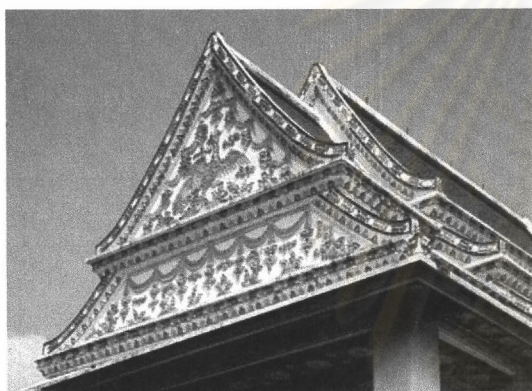
ภาพที่ 3-58 เครื่องปิดหลังคาอาคารเปรียญวัดเทพธิดาราม เครื่องปิดหลังคาแบบจีน ประดับกระเบื้องเคลือบ
