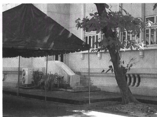
ภาพที่ 3-81 ฐานศาลาการเปรียญวัดพระศรีมหาธาตุ เป็นฐานบัวทึบที่มีช่วงท้องไม้สูง เพื่อทำเป็นช่องระบายอากาศ
