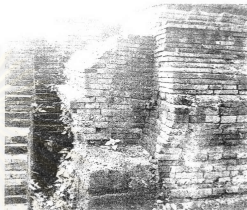
รูปที่ 5.2.22 ฐานบัวพระวิหารบริเวณมุขด้านหลังสมัยแรก วัดอรุณญิก เมืองพิษณุโลกที่ถูกก่อสร้างไว้
