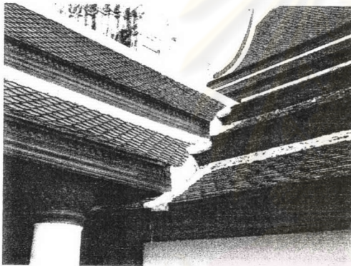
รูปที่ 5.2.89 หลังคาของพระระเบียงคดที่เข้าไปชนกับหลังคา ของพระวิหารมีการใช้ตะเข้วางเป็นปูนรับกระเบื้อง
