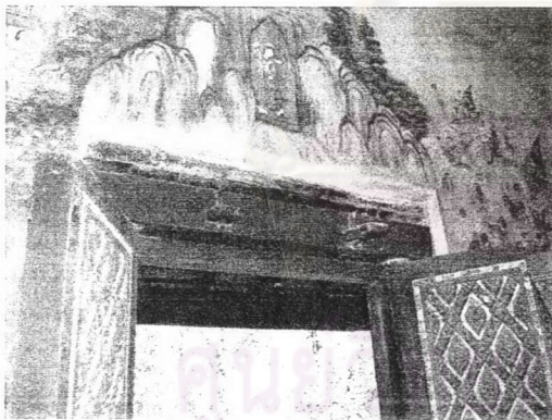
รูปที่ 5.2.44 ด้านบนของบานประตูไม้สำหรับยึดเดือย บานประตูกับกรอบเช็ดหน้าด้วยเดือยของฝักจำปาซึ่งทำให้สามารถถอดบานประตูได้ง่าย
