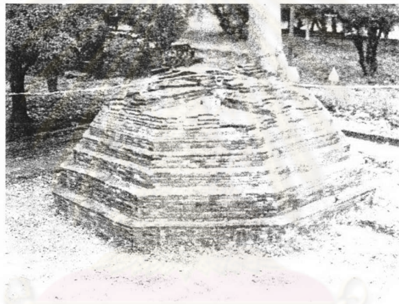
รูปที่ 5.2.79 แนวการก่ออิฐเพื่อเป็นแกนภายใน ฐานแปดเหลี่ยมขององค์เจดีย์
