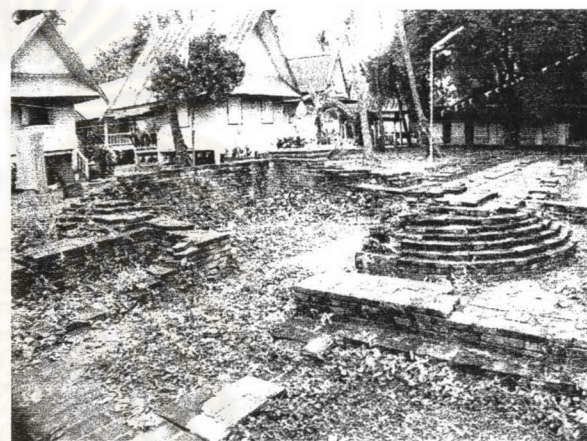
รูปที่ 3.4.21 ผนังก่ออิฐของซุ้มพระทิศใต้เป็นลักษณะโครงสร้างแบบผนังรับน้ำหนัก
