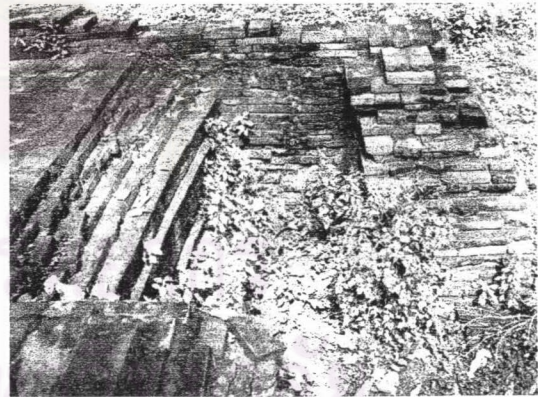
รูปที่ 3.4.38 อาคารที่ก่อฐานโดยรอบเป็นคลองรากและ ถมดินอัดแน่นไว้
