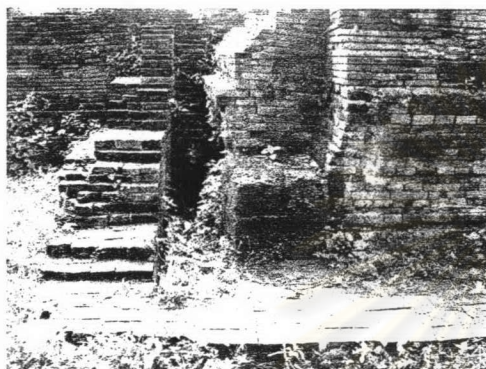
รูปที่ 3.4.12 ภาพด้านหลังของพระวิหารทางทิศตะวันออก แสดงให้เห็นเสาโครงสร้างสี่เหลี่ยมที่เป็นศิลาแลง
