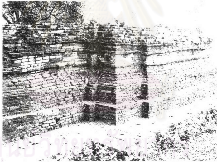
รูปที่ 3.4.43 ลักษณะบัวฐานและการต่อมุด้านหน้าของอาคารคันธกุฎี
