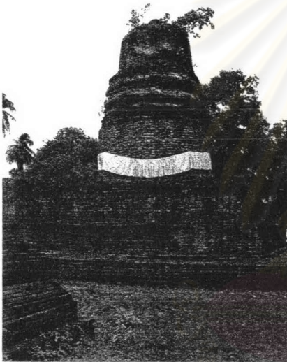
รูปที่ 3.4.2 ชั้นฐานเตี้ยพระเจดีย์ช้างล้อม ซ้อนกัน 3 ชั้น
