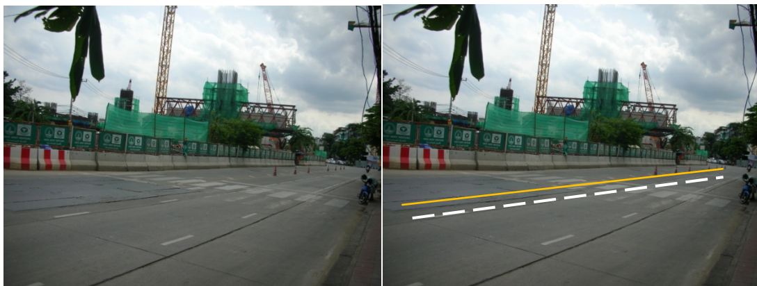
ภาพที่ 5.12 เส้นแบ่งทิศทางจราจรไม่ชัดเจน
