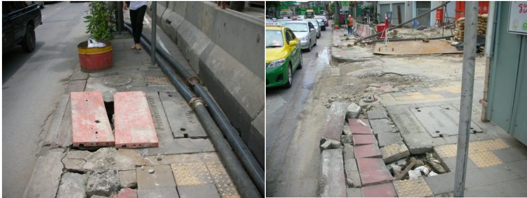
ภาพที่ 5.44 ช่องทางเดินเท้ามีหลุม และสภาพฝาที่ระบายน้ำชั่วคราวที่มีสภาพไม่สมบูรณ์
