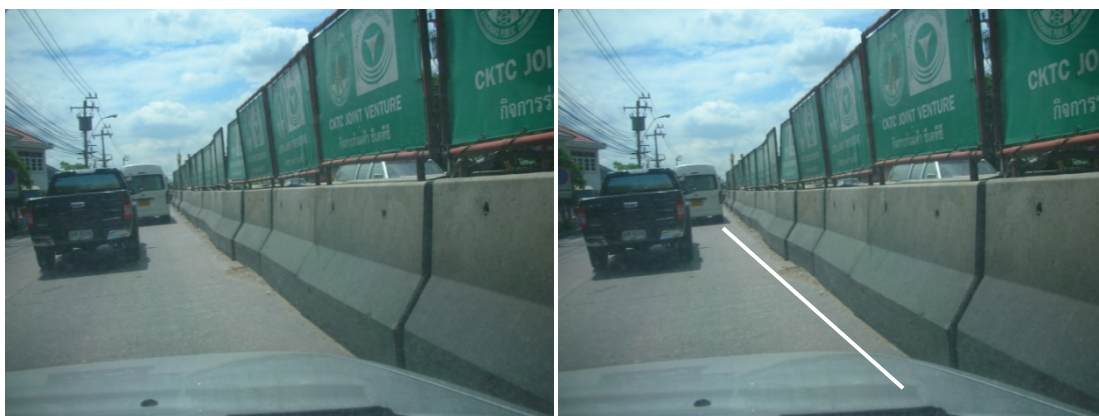
ภาพที่ 5.3 ไม่มีแนวเส้นเกาะกลางถนน
