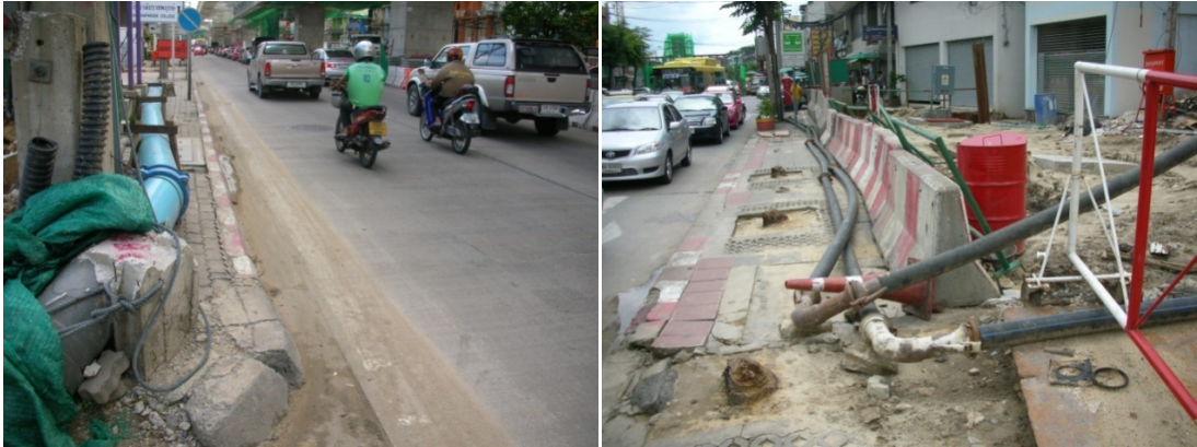
ภาพที่ 5.41 ท่อระบายน้ำหรือท่อลำเลียงเบนโทไนต์กีดขวางช่องทางเดินเท้า
