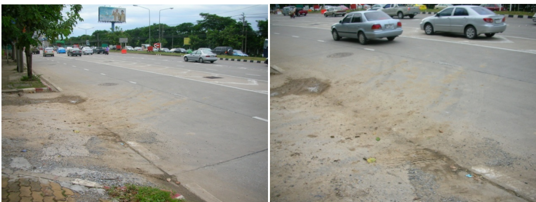
ภาพที่ 5.26 เศษดินและทรายบนพื้นผิวถนนบริเวณหน้าทางเข้าออกของพื้นที่ก่อสร้าง
