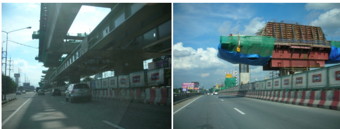
ภาพที่ 5.1 บริเวณพื้นที่ที่มีโครงสร้างอยู่ในระดับที่อาจถูกรถที่มีความสูงเฉี่ยวชนได้
