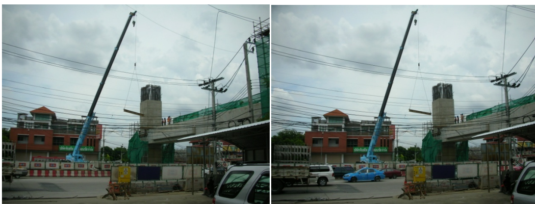
ภาพที่ 5.8 การยกวัสดุลูก้าออกมาบนพื้นที่จราจร
