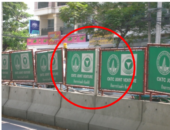
ภาพที่ 5.24 อุปกรณ์ส่องสว่างที่ติดตั้งตามแนวกำแพงคอนกรีต
