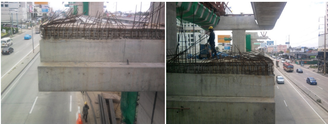
ภาพที่ 5.15 การกองเก็บวัสดุบนชั้นขยาดัวซึ่งมีลักษณะที่วัสดุอาจร่วงหล่นใส่ยานพาหนะได้
