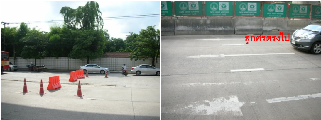
ภาพที่ 5.37 เครื่องหมายลูกศรบนผิวทางเดิมไม่ได้ปรับเปลี่ยนให้สอดคล้องกับจุดกลับรถข้างหน้า
