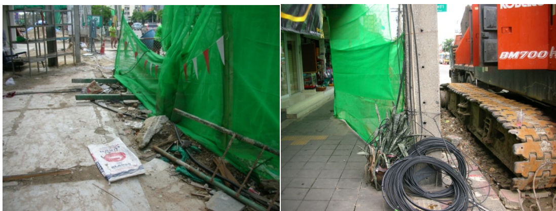
ภาพที่ 5.43 วัสดุยื่นออกมาจากเขตพื้นที่ก่อสร้างและกีดขวางช่องทางเดินเท้า
