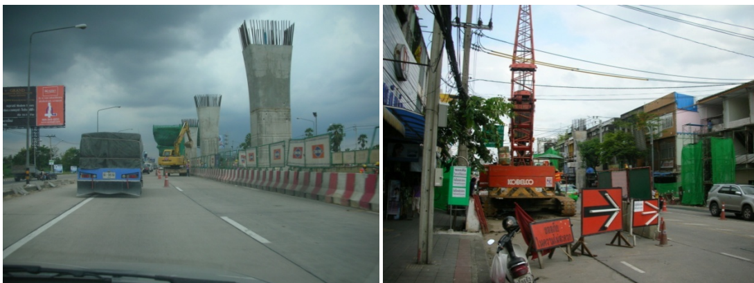
ภาพที่ 5.2 การลดความกว้างที่มีลักษณะไม่ปลอดภัย
