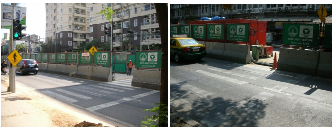
ภาพที่ 5.40 ทางม้าลายที่มีและไม่มีการติดตั้งสัญญาณไฟจราจรชั่วคราว
