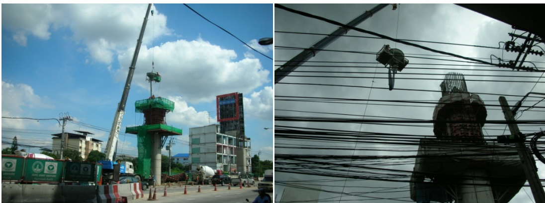
ภาพที่ 5.18 การเทคอนกรีตหล่อโครงสร้างส่วนบน
