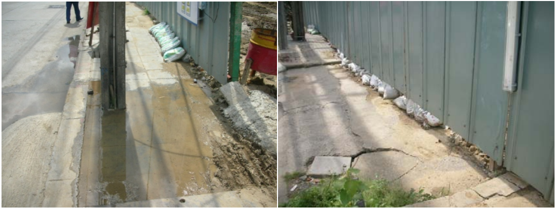
ภาพที่ 5.25 เศษดินและทรายบนพื้นผิวทางเดินเท้าบริเวณที่ชิดกับเขตก่อสร้าง และการใช้กระสอบทรายเพื่ออุดช่องว่างใต้แนวรั้วกำแพง
