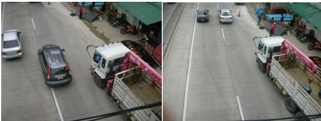
ภาพที่ 5.29 การให้สัญญาณการเข้าออกของเครื่องจักรที่ไม่มีประสิทธิภาพเพียงพอ
