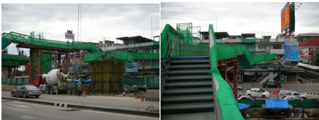
ภาพที่ 5.23 สะพานลอยชั่วคราวขาดแสงสว่างหรือไม่เพียงพอต่อการมองเห็นระหว่างการสัญจร
