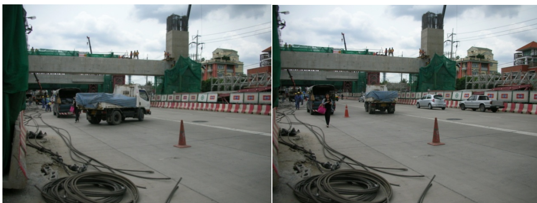
ภาพที่ 5.28 ขาดการให้สัญญาณระหว่างการเข้าออกของเครื่องจักร
