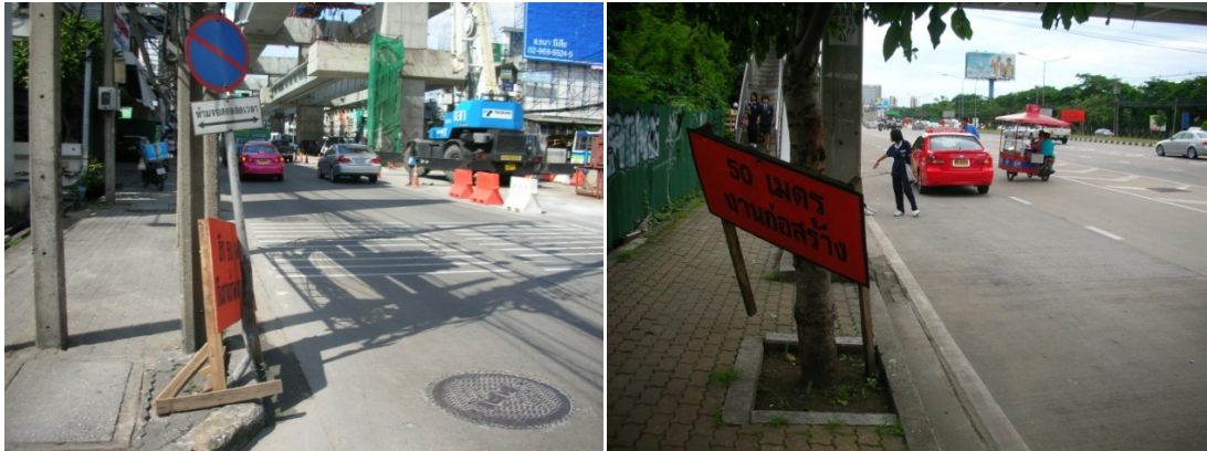
ภาพที่ 5.32 ป้ายจราจรอยู่ในสภาพที่สังเกตได้ยาก
