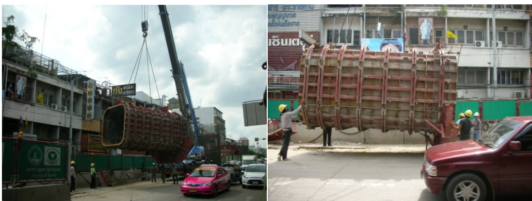
ภาพที่ 5.7 การขนย้ายวัสดุใกล้แนวพื้นที่จราจร
