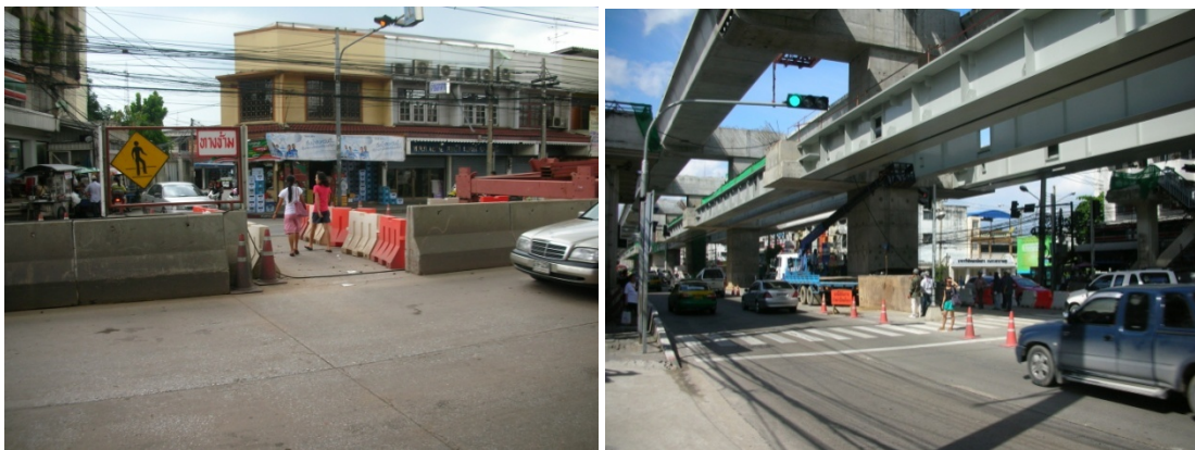
ภาพที่ 5.21 ไม่มีการป้องกันวัสดุที่อาจร่วงหล่นใส่คนเดินเท้าระหว่างการสัญจรผ่านทางม้าลาย
