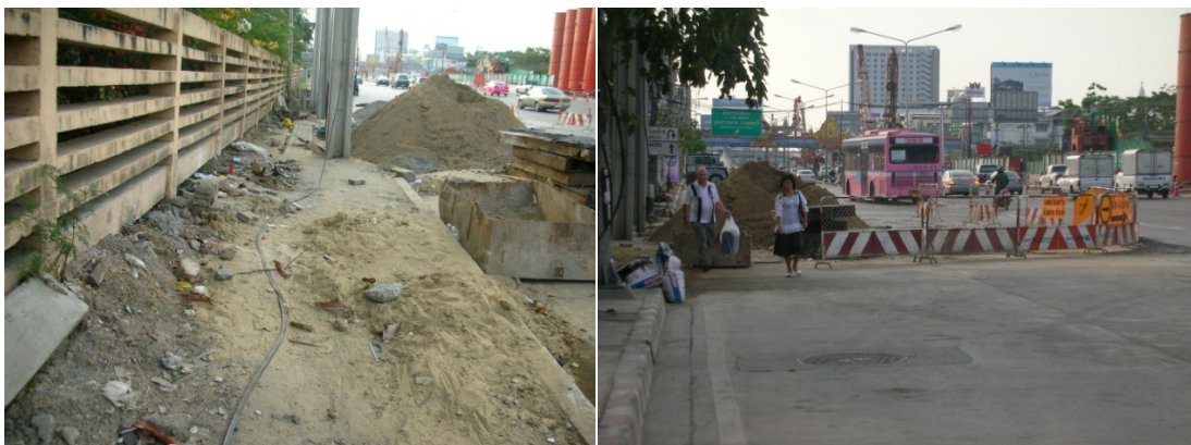
ภาพที่ 5.42 การกองเก็บเศษดิน ทราย หรือเศษวัสดุกีดขวางช่องทางเดินเท้า
