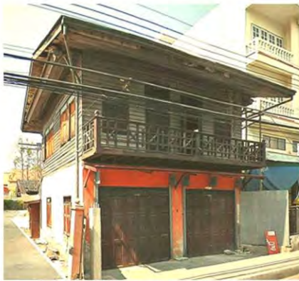
อาคารเก่าที่ดัดแปลงการใช้สอยเป็นร้านค้า ในชุมชนวัดศรีสุพรรณ 7
