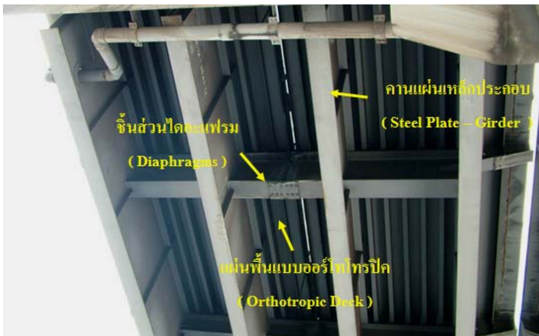
ภาพที่ 1.4 Orthotropic Steel Plate – Girder
