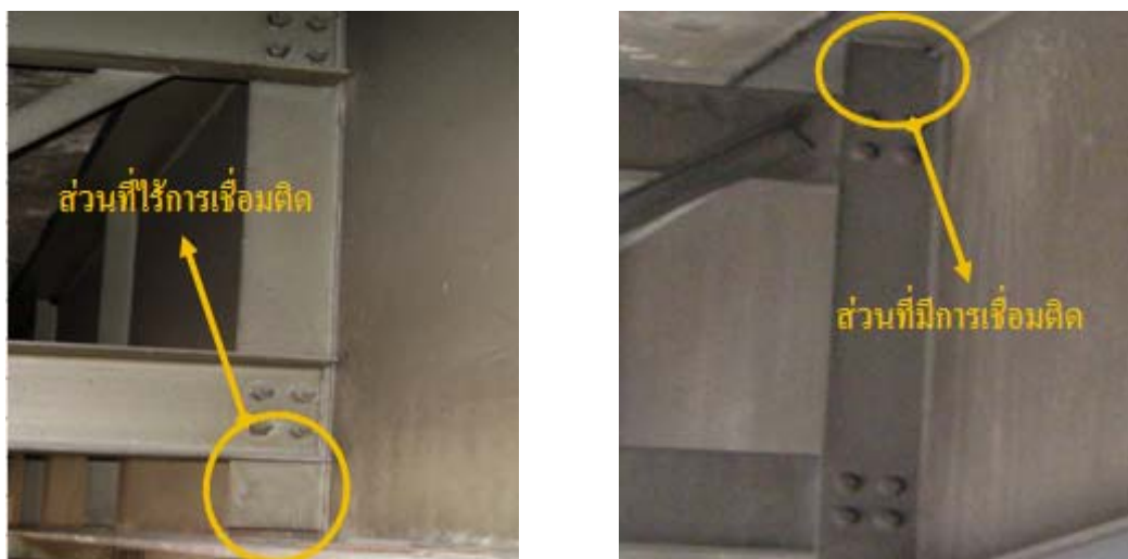
(a)บริเวณที่มีการเชื่อมติดกับชิ้นส่วนปีกของคาน (b)บริเวณไร้การเชื่อมติดกับชิ้นส่วนปีกของคาน ภาพที่ 1.1 แสดงชิ้นส่วนแผ่นเหล็กเสริมข้างคานที่ตำแหน่งที่เชื่อมกับชิ้นส่วนโครงเฟรมทางขวาง
