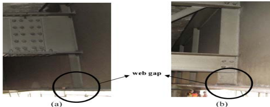
ภาพที่ 2.7 บริเวณ web gap (a) จากชิ้นส่วนไดอะแฟรม (b) จากชิ้นส่วนโครงเฟรมทางขวาง
