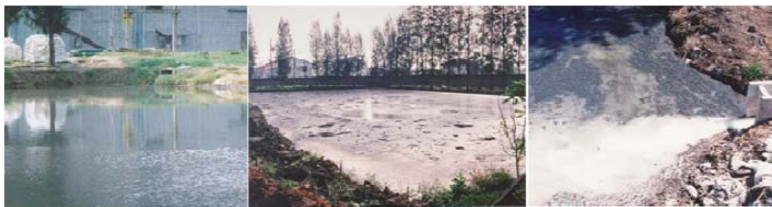
ภาพที่ 2.27 ระบบบำบัดแบบบ่อเปิด
