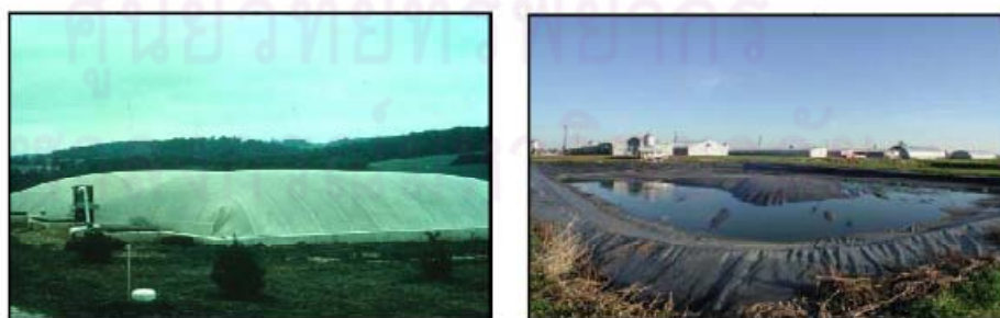
ภาพที่ 2.28 ระบบบำบัดแบบบ่อคลุม
