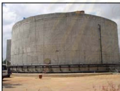
ภาพที่ 2.29 ถังผลิตก๊าซมีเทนของระบบยูเอเอสบี
