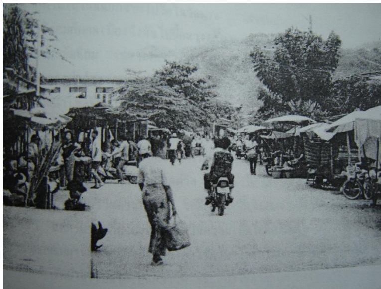
ภาพที่ 7 ตลาดไม้ลุงชนในอดีต 10
