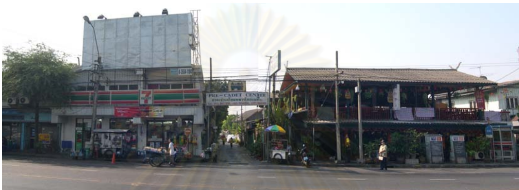
ภาพที่ 4.4 แสดงสภาพถนนซอยชุมชนสุขโขทัยซอย 9 เข้า-ออกสู่ถนนราชวิถี ที่มา : บันทึกเมื่อ ตุลาคม พ.ศ.2551
