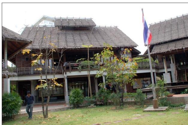
ภาพที่ 4.16 ภาพอาคารเรือนไทยประยุกต์ ของ สถาบันอาศรมศิลป์ ที่ทำการทดสอบวัดการรั่วซึมอากาศ
