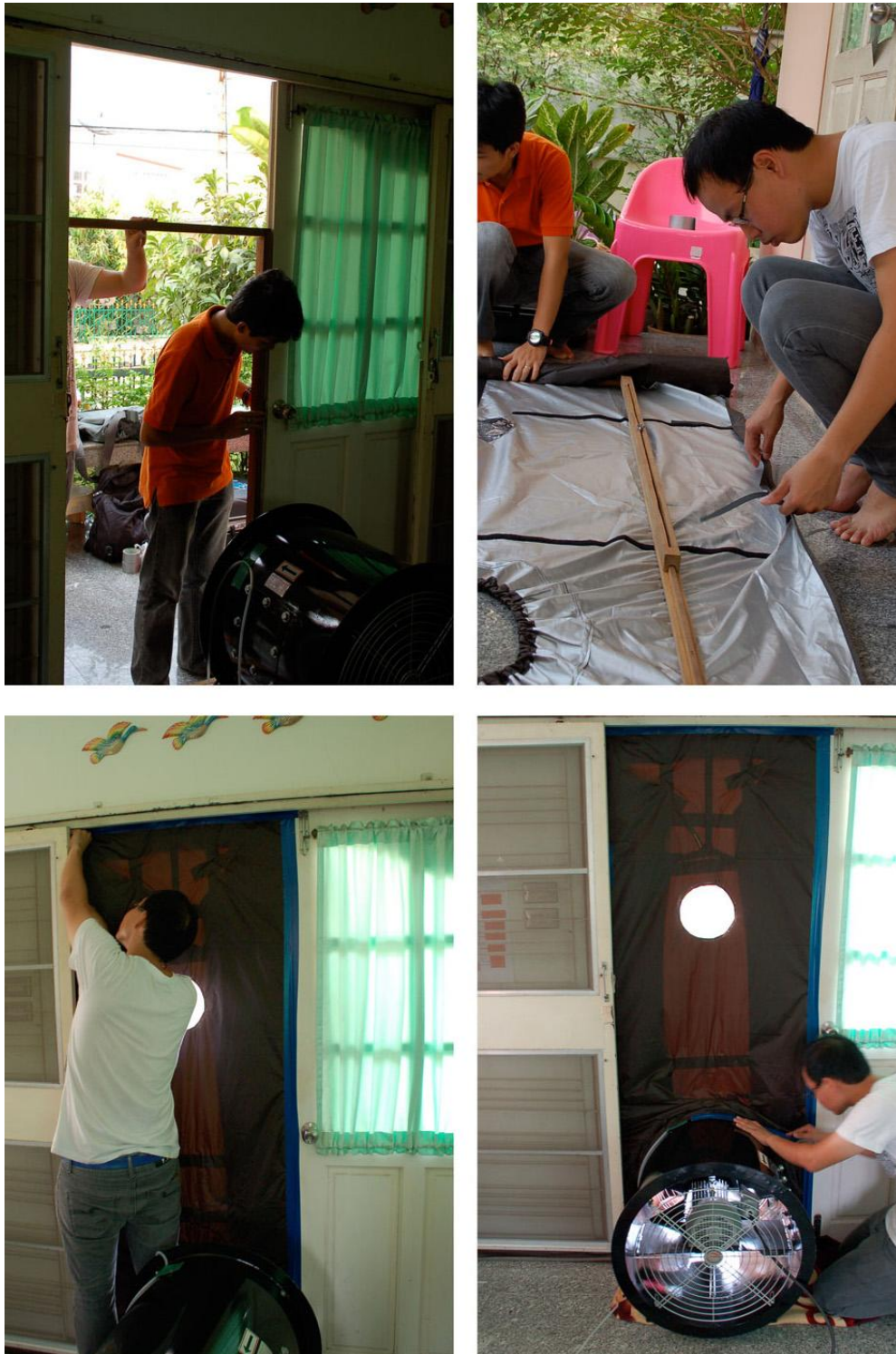
ภาพที่ 4.26 ภาพแสดงการติดตั้ง Blower Door และอุปกรณ์ในการวัดค่าการรั่วซึมอากาศ ในอาคารกรณีศึกษา “บ้านร่วมสมัย ของ คุณกัสดาพี กามีฮา”
