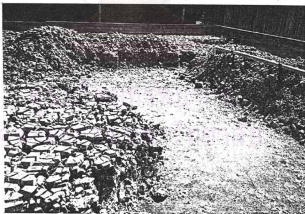
ภาพที่ 3.2 ตะกอนแห้งในลานตากตะกอนซึ่งมีการตัดออกไปบางส่วน
