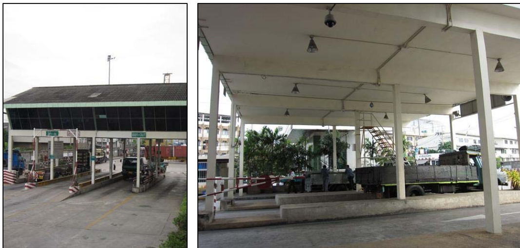
ภาพที่ 4-17 บริเวณ Gate ภายในท่าเรือ
