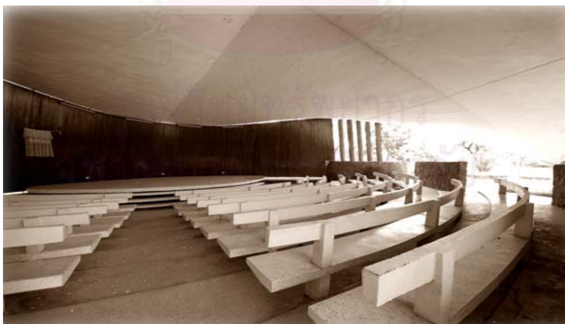
ภาพที่ 2.5 บริเวณภายในของอาคารครูสัมมนานครราชสีมาซึ่งเป็นโครงสร้างเปลือกแข็งบาง
