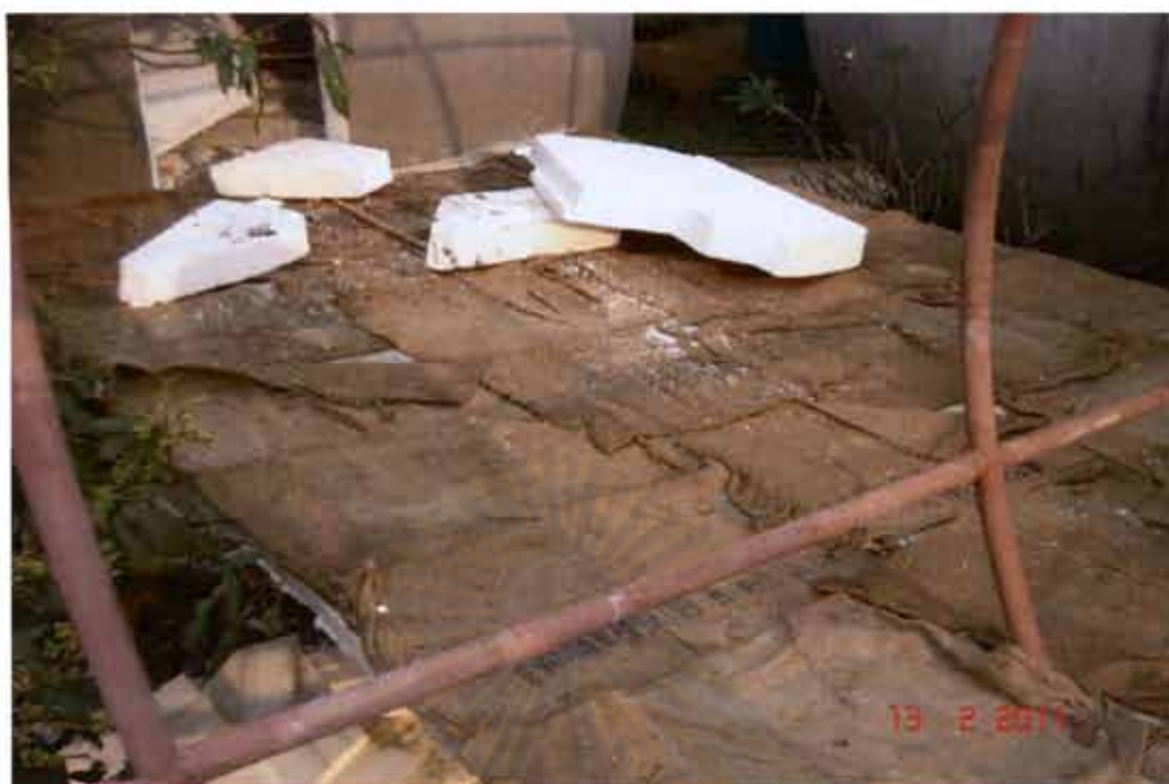
ภาพที่ 4.11 พื้นรูปแบบใหม่หลังจากออกแบบและก่อสร้างเสร็จ กำลังบ่มคอนกรีตติดต่อกัน 14 วันและจะถอดแบบเมื่อคอนกรีตมีอายุครบ 14 วัน
