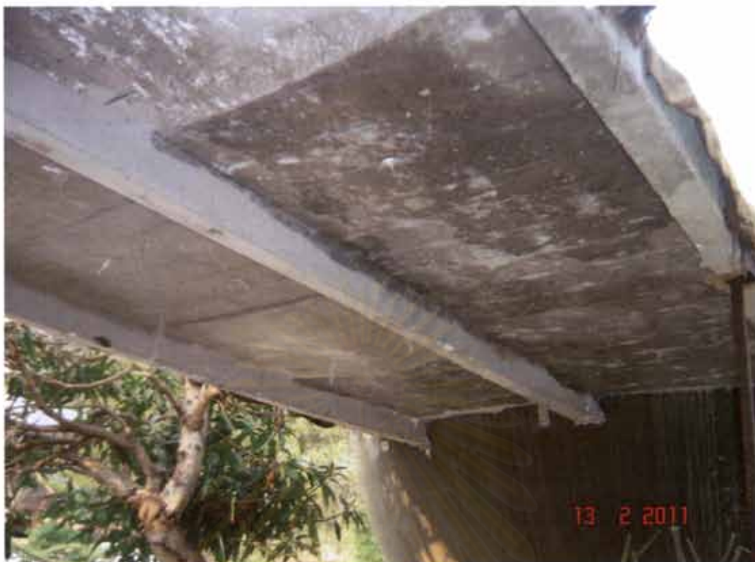
ภาพที่ 4.13 ด้านล่างของพื้นรูปแบบใหม่ เชื่อมยึดติดกับโครงสร้างอาคารทรงกลม
