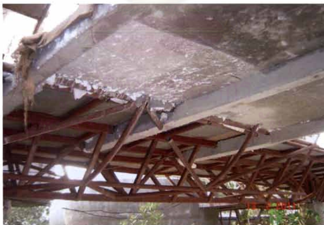
ภาพที่ 4.12 ด้านล่างของพื้นรูปแบบใหม่ เชื่อมยึดติดกับโครงสร้างทางเดินที่ระหว่างอาคาร
