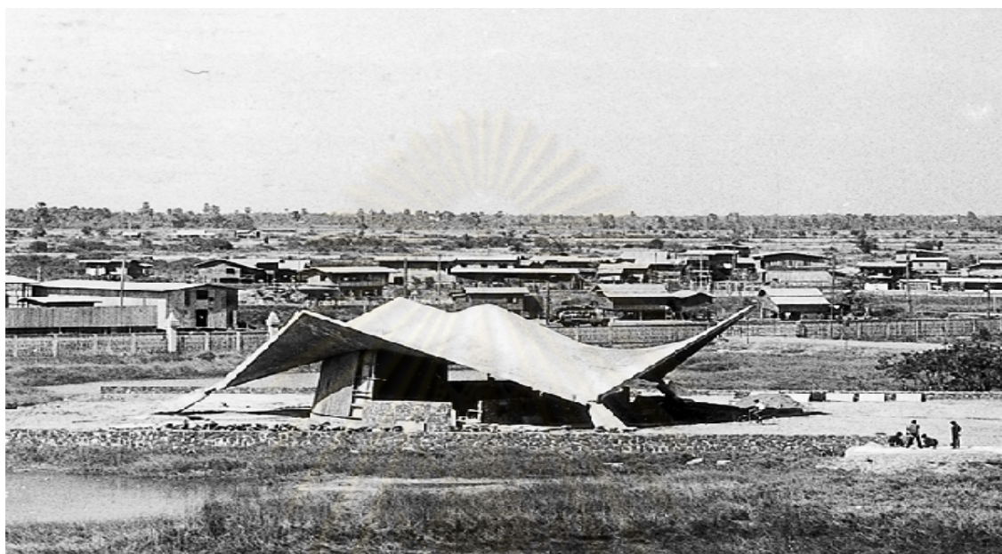
ภาพที่ 2.4 บริเวณภายนอกของอาคารครูสัมมนานครราชสีมาซึ่งเป็นโครงสร้างเปลือกแข็งบาง
