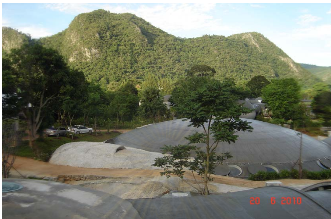
ภาพที่ 2.1 บริเวณภายนอกของอาคารโดมโครงสร้างเปลือกบางด้วยโฟม
