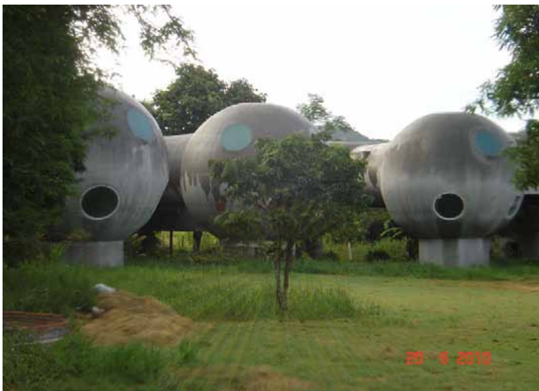
ภาพที่ 2.3 อาคารบ้านพัก DNA Resort เขาใหญ่ จ.นครราชสีมา ซึ่งมีความสูง 2 ชั้นโดยโครงสร้างอาคารหลักเป็นโฟม
