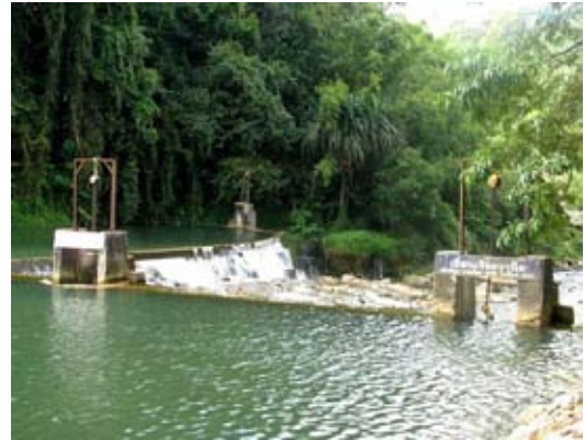
18. เขื่อนเจียรวานิชไว้สำหรับเปิดปิดน้ำ
