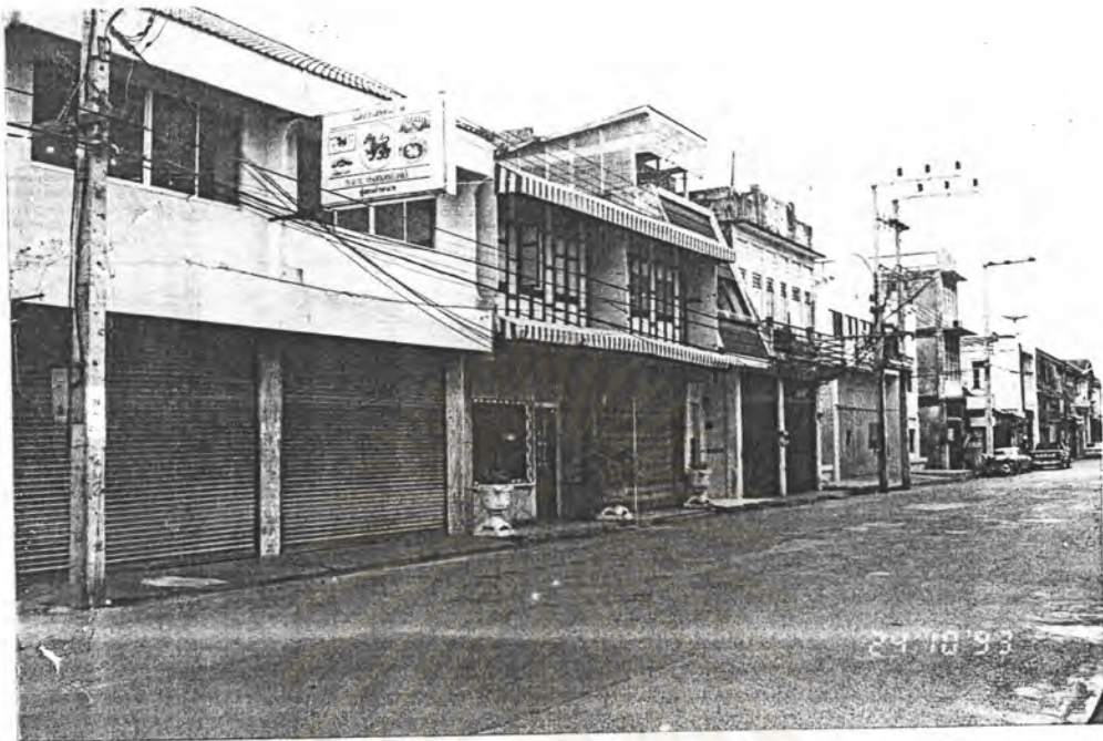
ภาพที่ 4.5 . ซาเวือและโกดังบนถนนนครนอก ซึ่งมีขนาดใหญ่กว่าอาคารอื่น และ มีองค์ประกอบที่ค่อนข้างซับซ้อนกับอาคารโดยรวม
