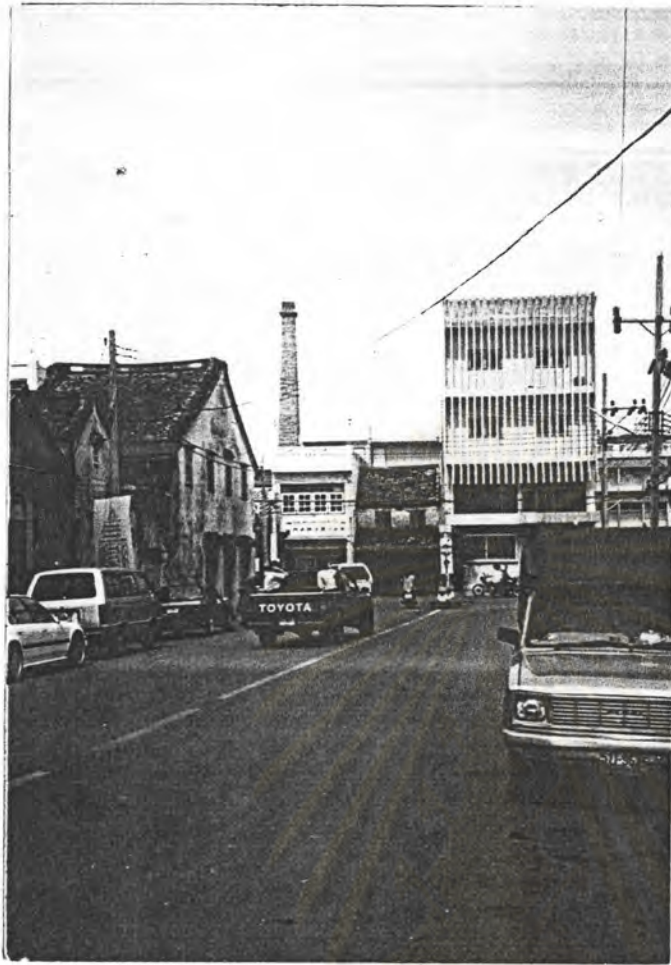
ภาพที่ 4.11 มุมมองจากถนนสาย- บุรี จะสังเกตเห็น ที่หมายตาที่เป็นอาคาร สมัยใหม่ ซึ่งไม่มี คาทางสถาปัตยกรรม
