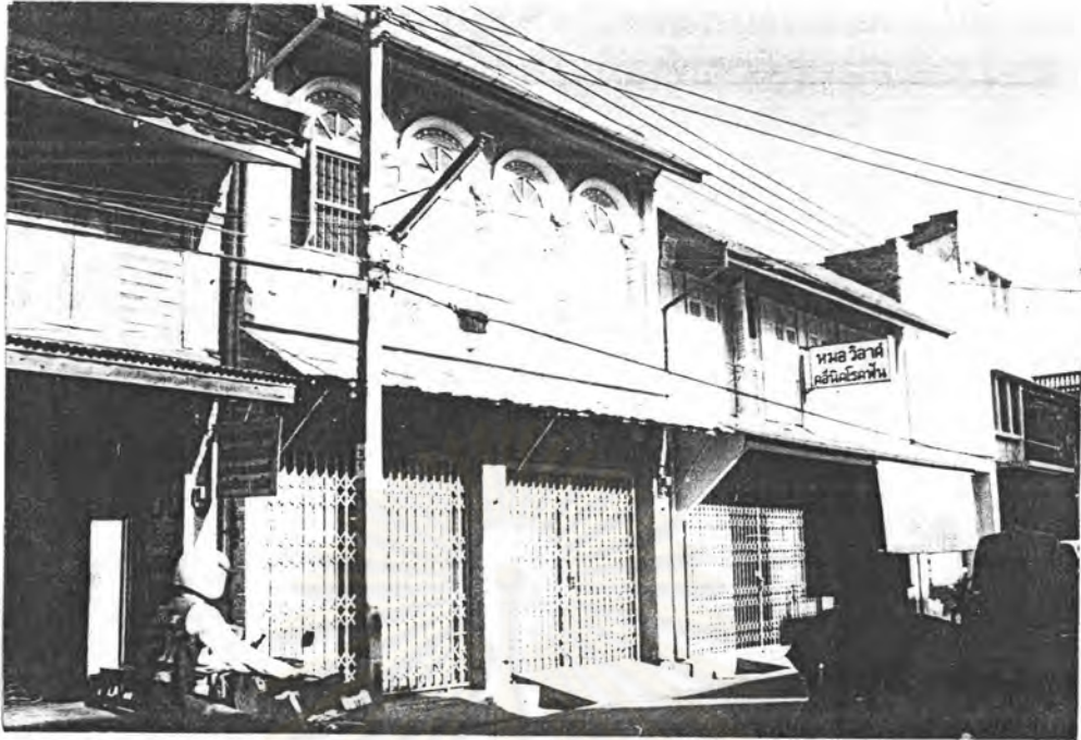
ภาพที่ 4.35 อาคารแถวบริเวณถนนนครในซึ่งส่วนใหญ่จะเป็นอาคาร 2 ชั้นและมีรูปแบบเฉพาะตัวต่างจากอาคารสมัยใหม่ โดยทั่วไป
