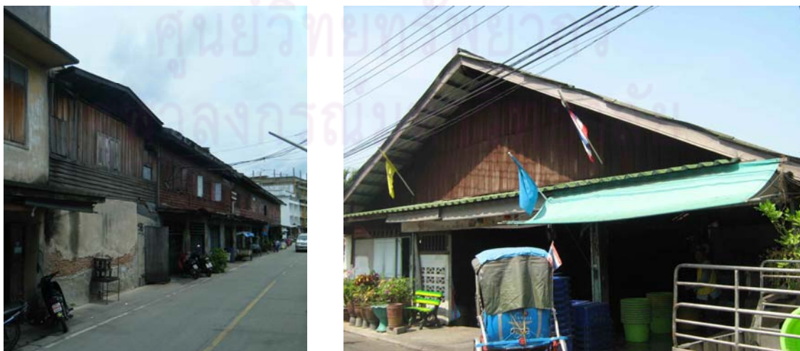
อาคารประเภทที่พักอาศัยกิ่งพาณิชยกรรม อาคารประเภทโรงงานอุตสาหกรรมประมงขนาดเล็ก “ลั้ง”
