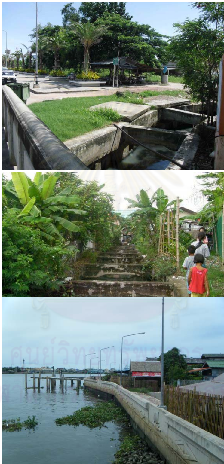
ภาพที่ 5.21 แสดงระบบระบายน้ำและแนวเขื่อนป้องกันน้ำท่วมในชุมชนท่าฉลอม ที่มา: จากการสำรวจเมื่อเดือน มิถุนายน พ.ศ.2553
