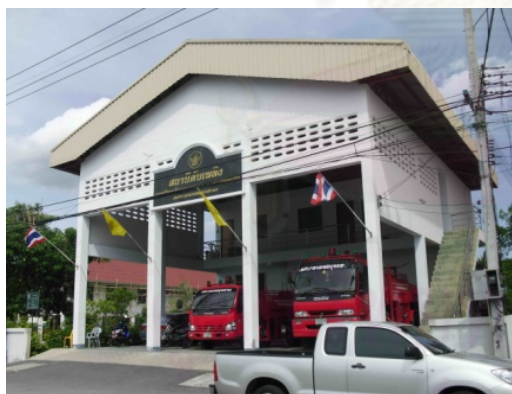
สถานีดับเพลิงท่าฉลอม
