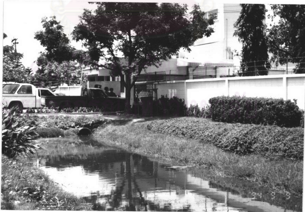
ภาพที่ 8. แสดงตำรากระบายน้ำฝนหน้าโรงงานลำสูง (ประเทศไทย) จำกัด
