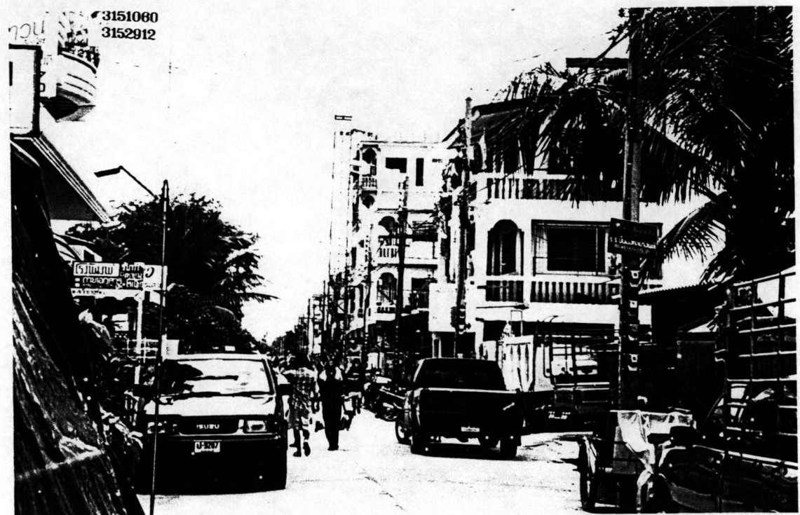
ความไม่เป็นระเบียบ จากการต่อเติมอาคารของบ้านสร้างบางส่วน
