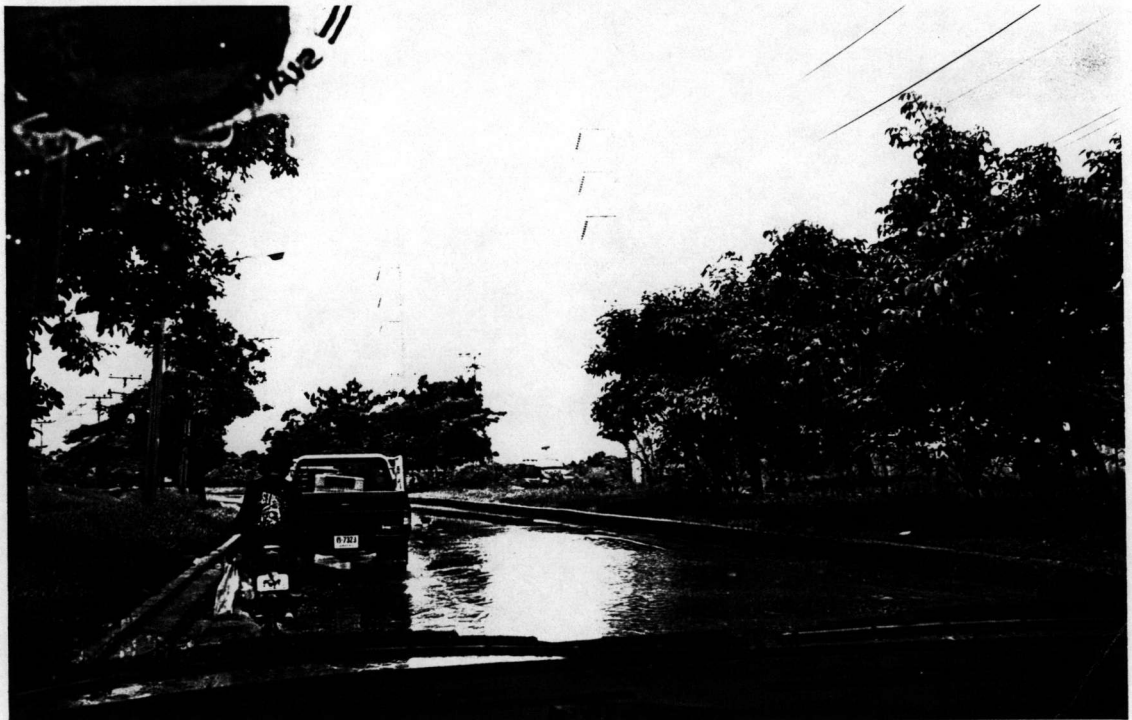
น้ำท่วมขังภายในโครงการเนื่องจากท่อระบายน้ำอุดตัน
