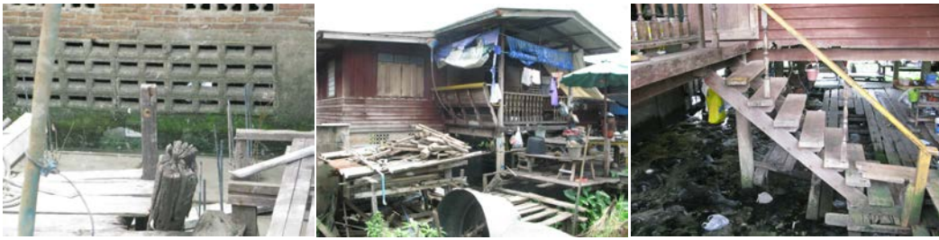
รูปภาพ5.8 แสดงภาพก่อนการปรับปรุงบ้านนางสาวเจริญ ตุ่มเพชร
