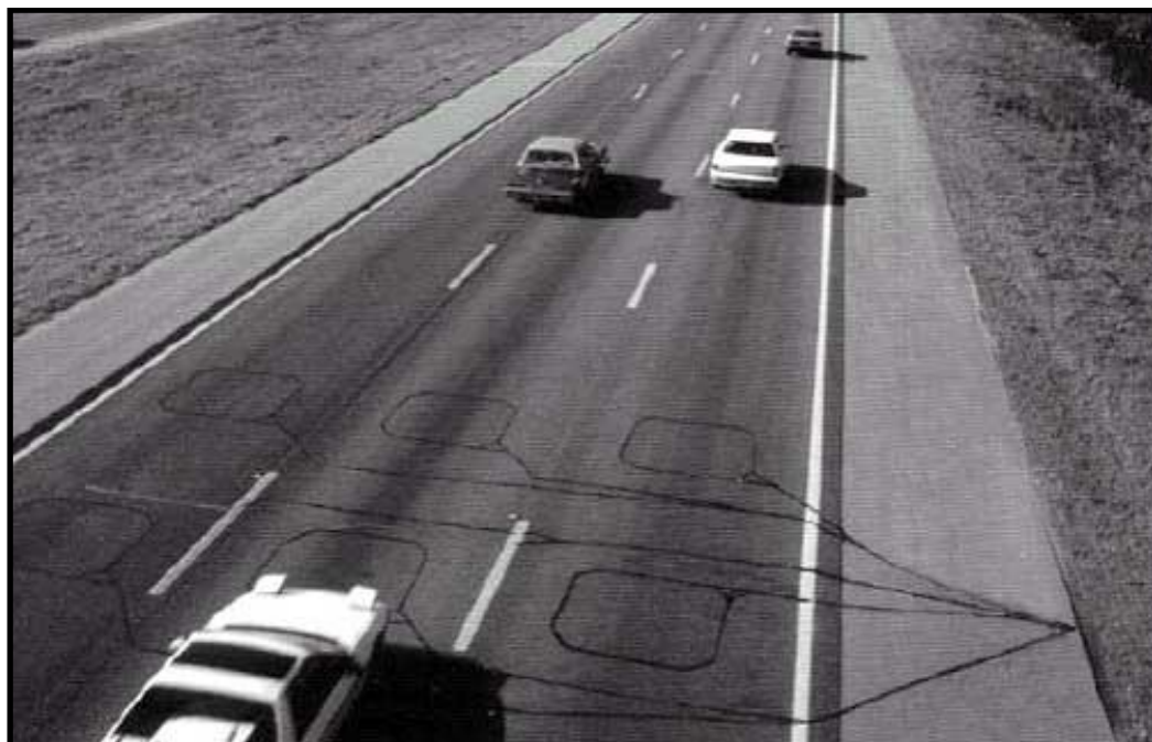
รูปที่ 2.5 Inductive loop detector
