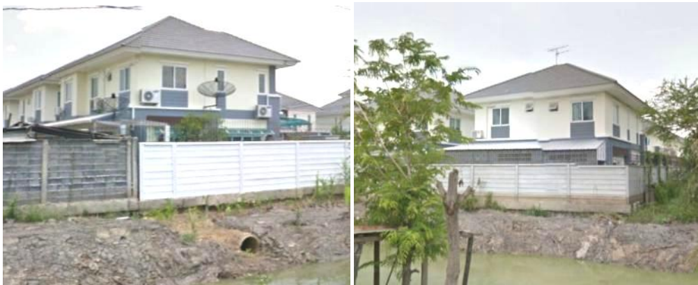
ภาพที่ 4.54 แสดงลักษณะรั้วที่ติดกับโครงการข้างเคียง และด้านหลังโครงการ
