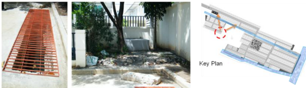
ภาพที่ 5.18 แสดงการขยายบ่อพักน้ำ ให้เป็นบ่อสูบน้ำที่เชื่อมต่อกับลำราง
