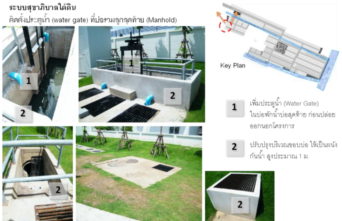
ภาพที่ 5.15 แสดงลักษณะของประตูน้ำ (Water Gate) ที่บ่อพักน้ำจุดสุดท้าย (Manhole) บริเวณงานระบบสุขาภิบาล จุดที่ 1
