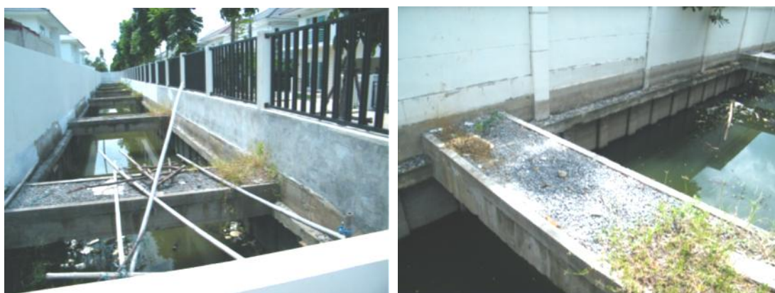
ภาพที่ 4.30 แสดงรั้วเชื่อมโครงการ แบบผนังรั้วเป็นผนังรั้วคอนกรีตสำเร็จรูป
