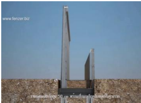
ภาพที่ 2.16 แสดงการก่อสร้างรั้ว 2 ชั้น โดยชั้นแรกสูง 2.75 ม. และชั้นที่ 2 สูง 0.50 ม.
