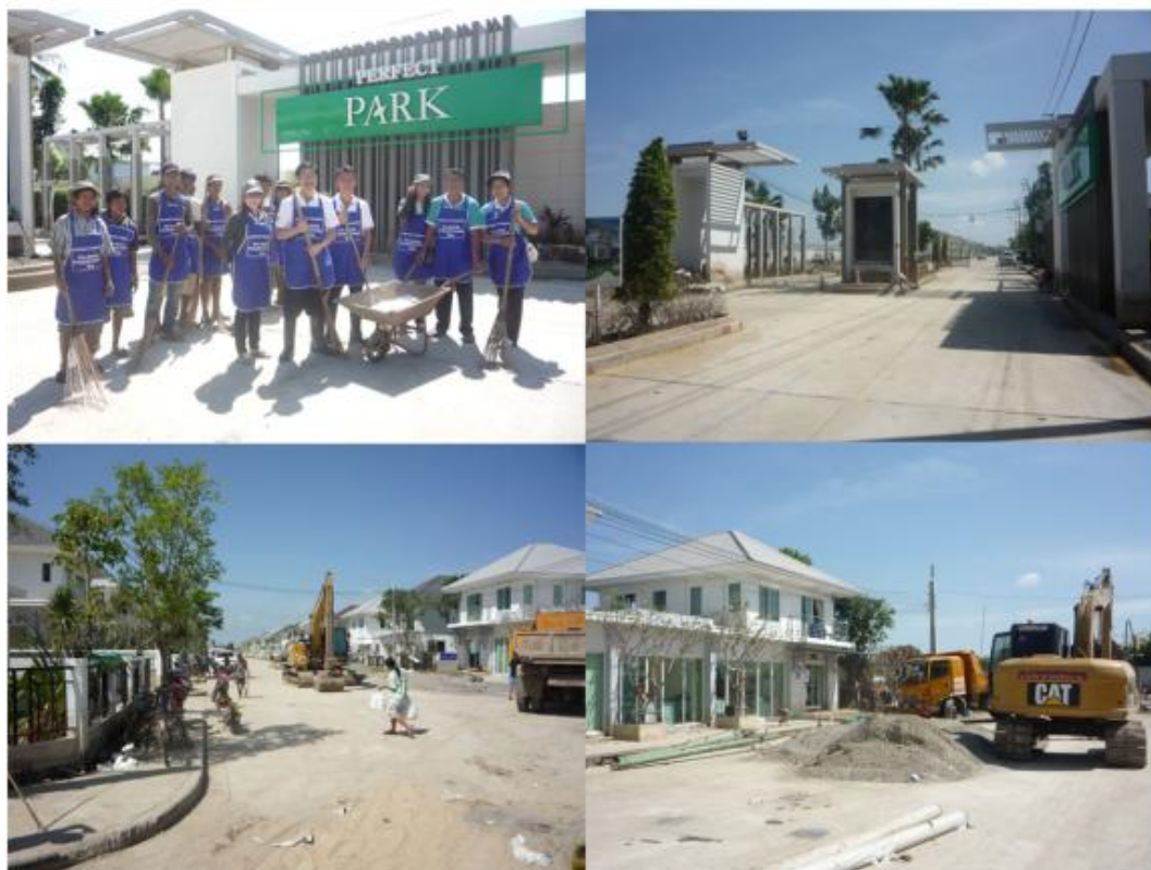
ภาพที่ 4.41 แสดงการทำความสะอาดโครงการ หลังน้ำลด
