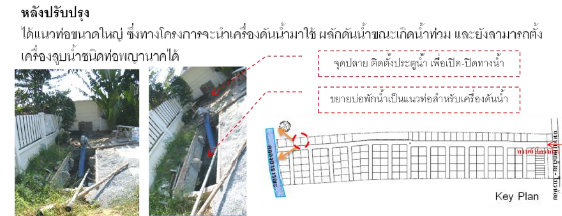
ภาพที่ 5.29 แสดงการขยายขนาดบ่อสูบ เพื่อติดตั้งเครื่องต้นน้ำ และสามารถวางเครื่องสูบน้ำชนิดท่อพญานาค
