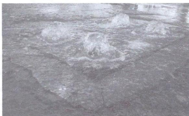
ภาพที่ 2.6 แสดงน้ำไหลเข้าบ่อพักระบายน้ำ
