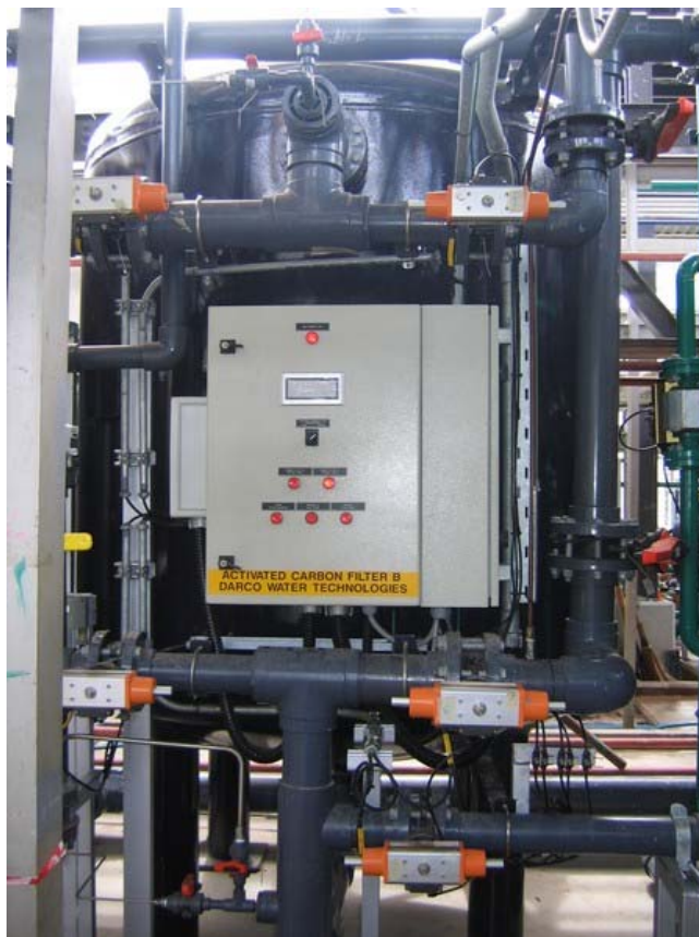
รูปที่ 1.10 Activated Carbon Filter
