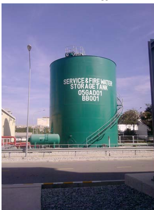
รูปที่ 1.9 ถังเก็บน้ำประปา
