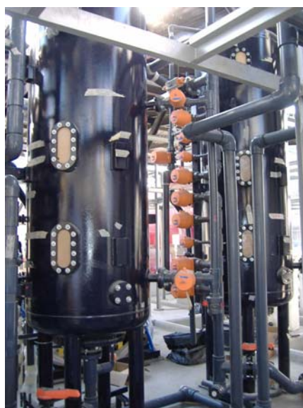
รูปที่ 1.13 Mixed Bed Exchanger
