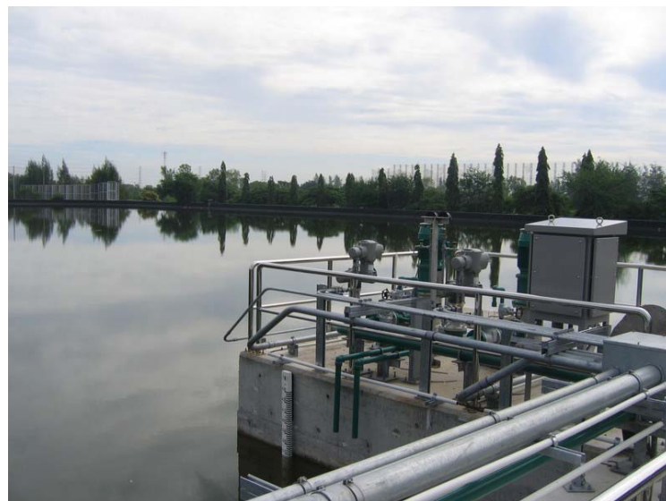
รูปที่ 1.7 อ่างเก็บน้ำดิบ (Site Reservoir) ของ โรงไฟฟ้าบางปะกง
