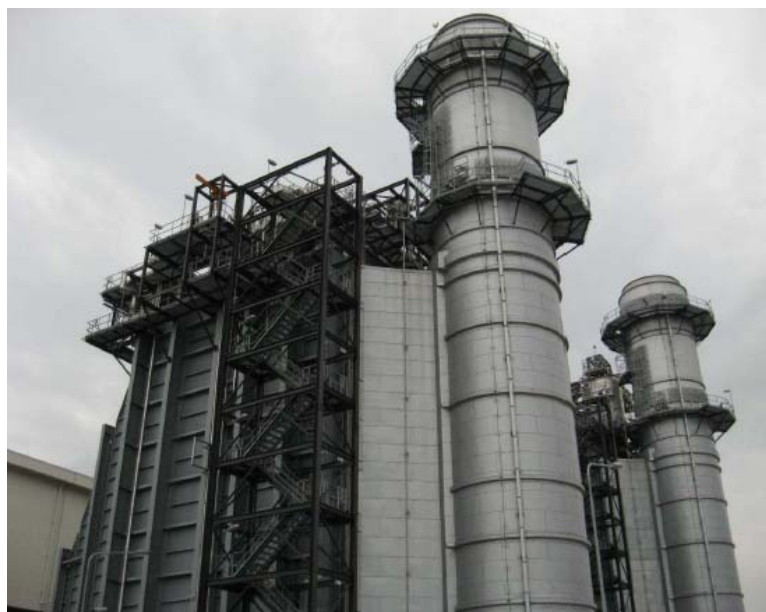
รูปที่ 1.4 เครื่องกำเนิดไอน้ำ
