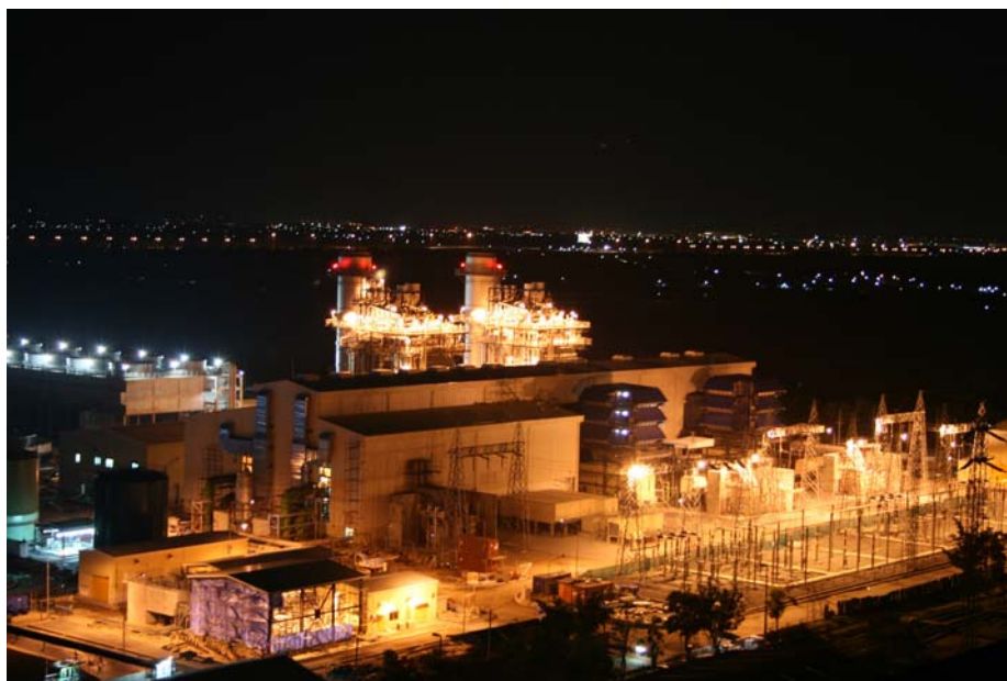
รูปที่ 1.1 โรงไฟฟ้าพลังความร้อนร่วมบางปะกงชุดที่ 5
