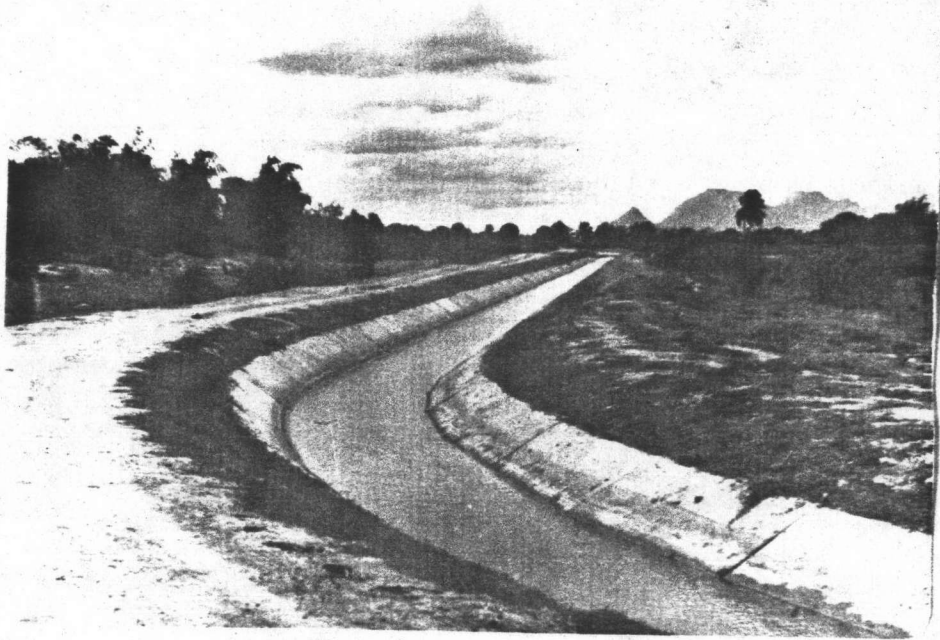
รูป 1-3 คลองแยกขอยตาดพนมด้วยคอนกรีต อ. ปราณบุรี จ. ประจวบคีรีขันธ์
