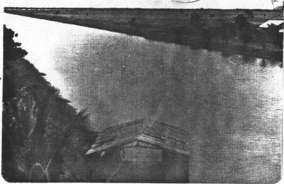
รูป 1-1 คลองส่งน้ำสายใหญ่เป็นคลองดิน จ. ชัยนาท
