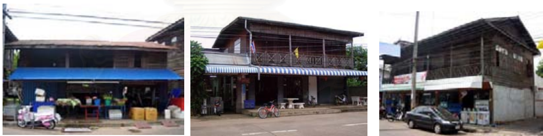
รูปที่ 6.21 แสดงเรือนแถวอยู่อาศัยกิ่งคำชายที่มีการต่อเติมกันสาด
