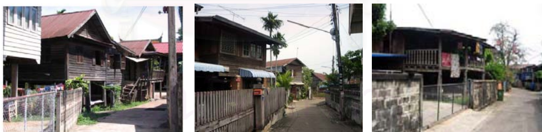
รูปที่ 6.46 แสดงสภาพถนนภายในชุมชนที่มีขนาดเล็กทำให้รถดับเพลิงเข้าถึงได้ยาก
