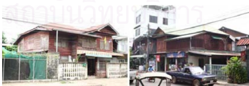
รูปที่6.25 แสดงเรือนที่อยู่อาศัยแบบคหบดีที่มีการต่อเติมห้องด้านหน้า
