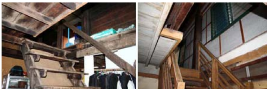
รูปที่ 6.26 แสดงเรือนที่อยู่อาศัยแบบคหบดีที่มีต่อเติมบันไดภายในบ้าน
