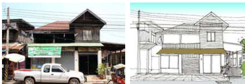
รูปที่ 7.13 แสดง การปรับปรุงผ้าใบบังแดดเรือนที่อยู่อาศัยแบบคหบดีบนถนนเจริญเมือง
