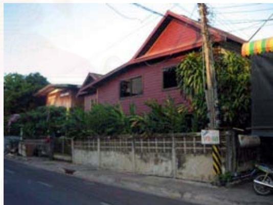
หลังปรับปรุง และพื้นที่
