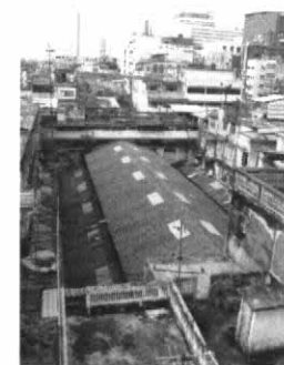
E5 ขาดทางหนีไฟและอุปกรณ์ดับเพลิง
