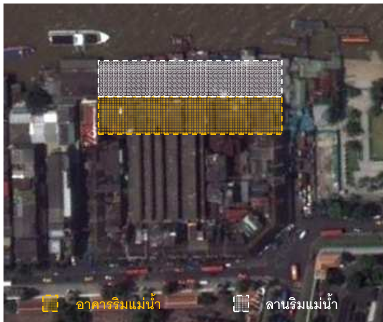
ภาพที่ 3-21 ตำแหน่งอาคารแถวริมแม่น้ำที่สร้างในสมัยรัชกาลที่ 7
