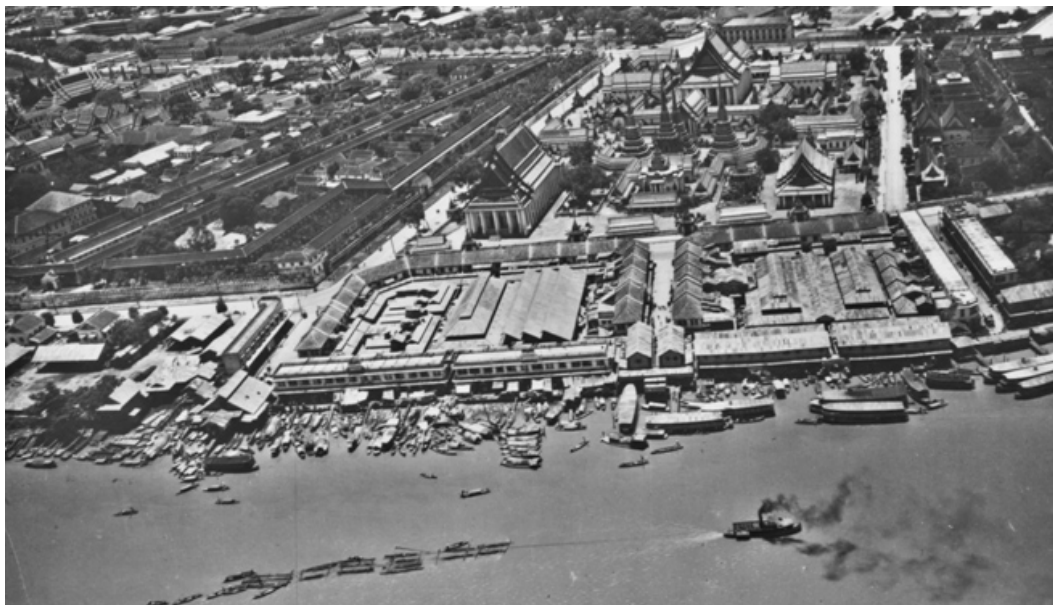
ภาพที่ 1-6 สภาพตลาดท่าเตียนและตลาดเพ็ญพัฒน์ในสมัยรัชกาลที่ 5 โดยกลุ่มอาคารกลางภาพคือตลาดท่าเตียนและกลุ่มอาคารด้านขวาคือตลาดเพ็ญพัฒน์ ที่มา : หอจดหมายเหตุแห่งชาติ
