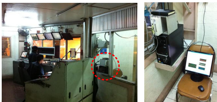
รูปที่ 5.3 การติดตั้งระบบตรวจสอบการเกิดฟองสแตก
