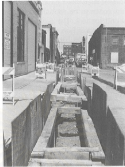
รูปที่ 2-3 แสดงการก่อสร้างโดยวิธีขุดเปิดหน้าดิน
