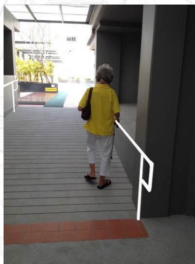
ภาพที่ 5.19 ภาพแสดงการติดตั้งราวจับทางลาดสระว่ายน้ำ
