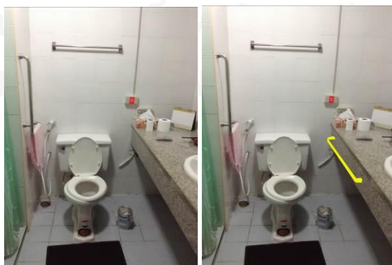
ภาพที่ 5.5 ภาพแสดงการติดตั้งราวจับบริเวณชักโครก
