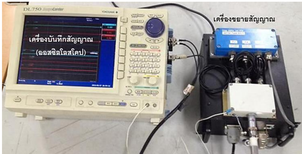
รูปที่ 3.12 การติดตั้งเครื่องขยายสัญญาณและเครื่องบันทึกสัญญาณ
