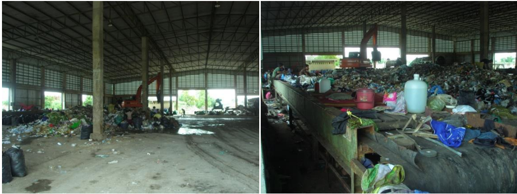
รูปที่ 4.8 รถตัดขยะคัดแยกขยะมูลฝอยในบริเวณอาคาร
