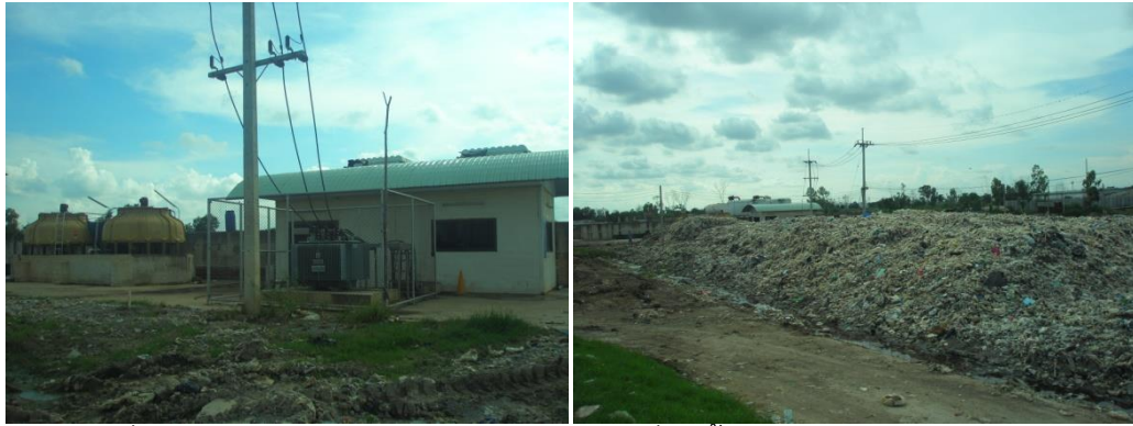
รูปที่ 4.11 อาคารควบคุมหม้อแปลง และขยะที่นำขึ้นจากบ่อหมักหลังหมักแล้ว
