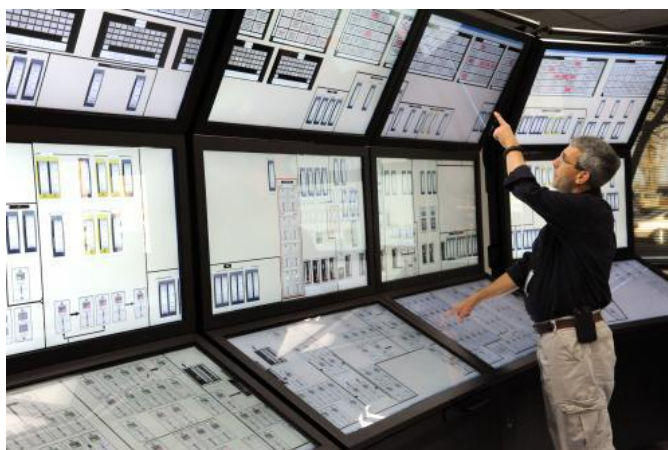
รูปที่ 1.8 การใช้งานจอภาพในห้องควบคุมของโรงไฟฟ้านิวเคลียร์
