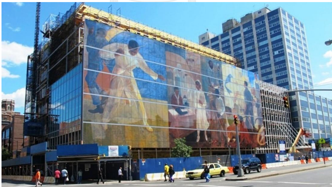
ภาพที่ ก. 17 กระจกที่พิมพ์ลายโดยระบบดิจิทัล [30]
