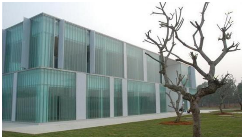
ภาพที่ ก. 28 กระจกชั้นรูปตัวยู (U-Shaped Glass) [41]
