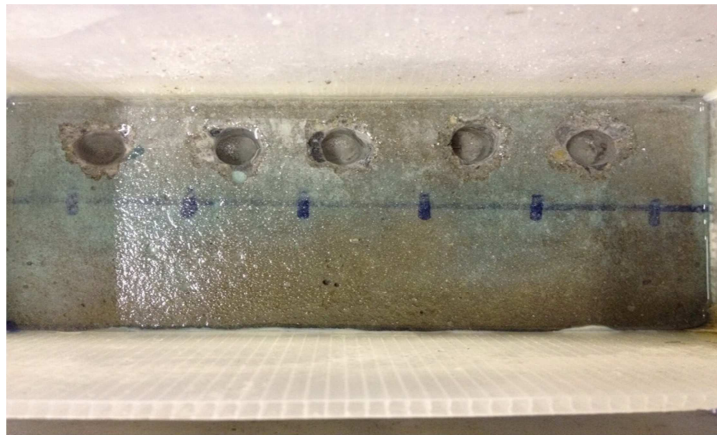
รูปที่ 3.11 การเจาะผิวคอนกรีตเพื่อลดระยะหุ้มคอนกรีต
