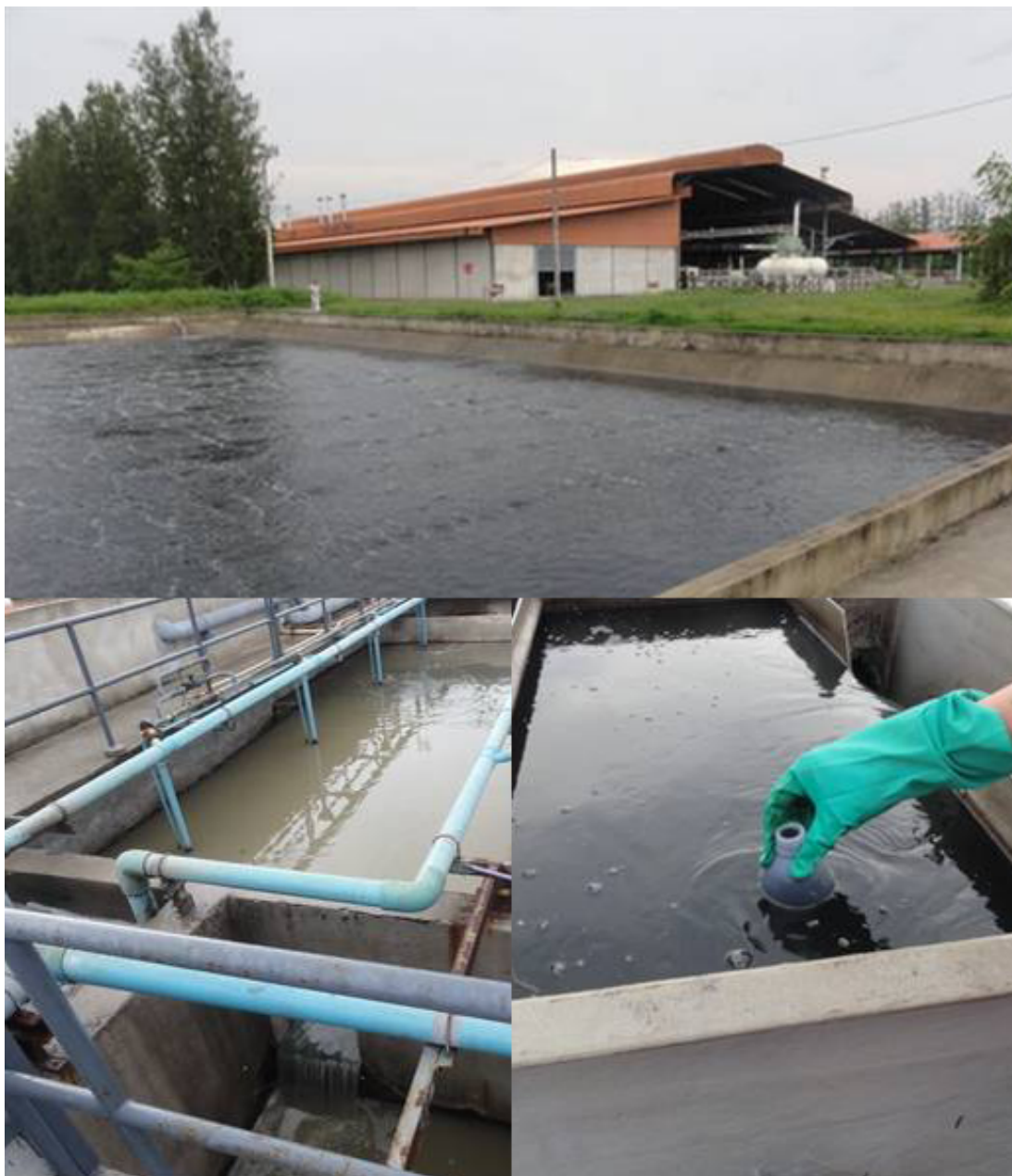
ภาพที่ 4 พื้นที่เก็บตัวอย่างน้ำ บ่อเก็บน้ำหลังการบำบัดของโรงงานยางพารา จังหวัดระยอง
