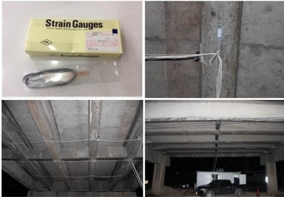
รูปที่ 3.11 มาตรการวัดความเครียดและการติดตั้ง ณ สะพานที่ทำการทดสอบ
