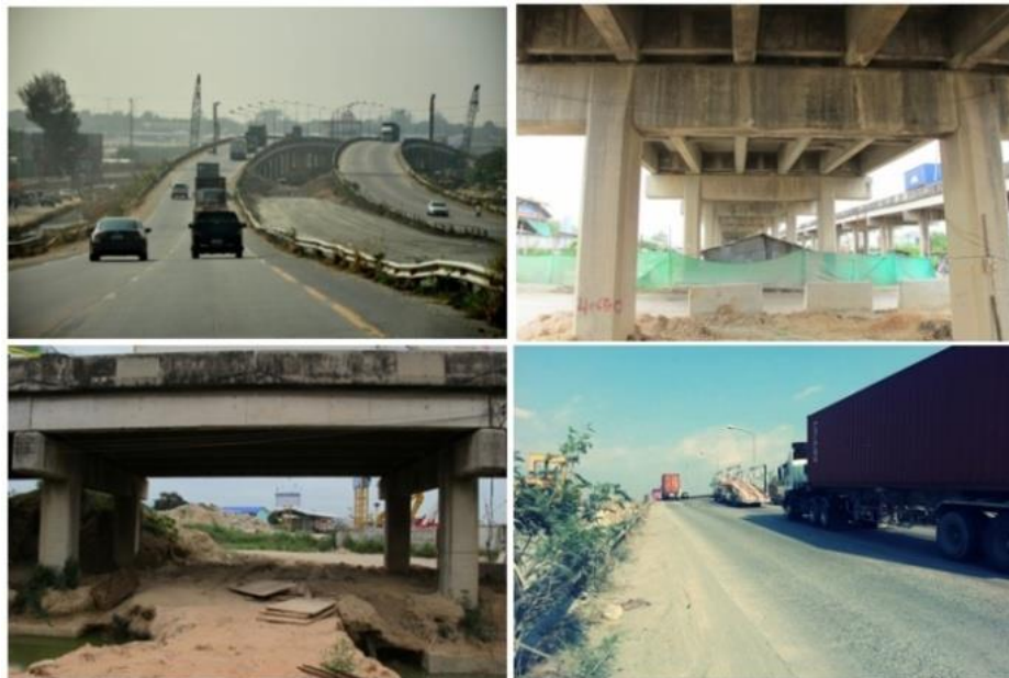
รูปที่ 3.2 มุมมองต่างๆ บริเวณสะพานตัวอย่างที่ทำการทดสอบ
