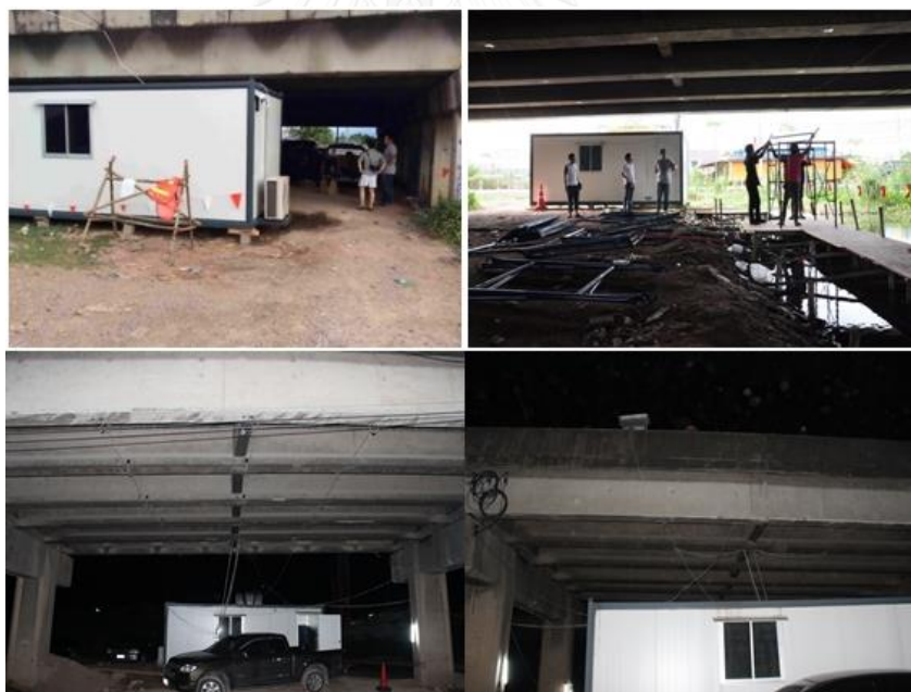
รูปที่ 3.9 การติดตั้งตู้คอนเทนเนอร์เพื่อใช้ในการดำเนินงานตรวจวัดที่ใต้สะพาน
