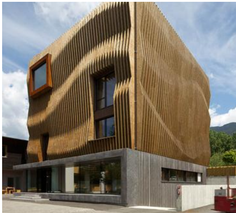
ภาพที่ 1 ตัวอย่างอาคารที่ใช้แผงกันแดดแนวตั้ง
