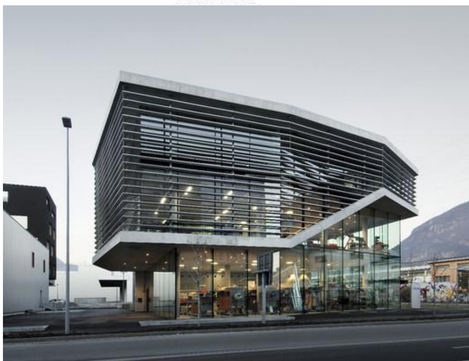
ภาพที่ 6 ตัวอย่างอาคารที่ใช้แผงกันแดดแนวนอน
