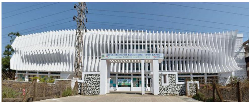
ภาพที่ 3 ตัวอย่างอาคารที่ใช้แผงกันแดดแนวตั้ง
