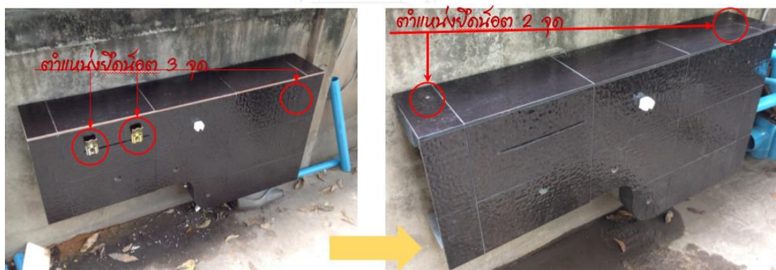
ภาพที่ 3.19 ปรับตำแหน่งการยึดน็อตให้สามารถติดตั้งได้ง่ายขึ้น
