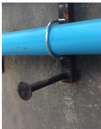
ภาพที่ 3.17 เพิ่มจุดค้ำยันบริเวณด้านล่างของแกนเหล็กรับท่อ
