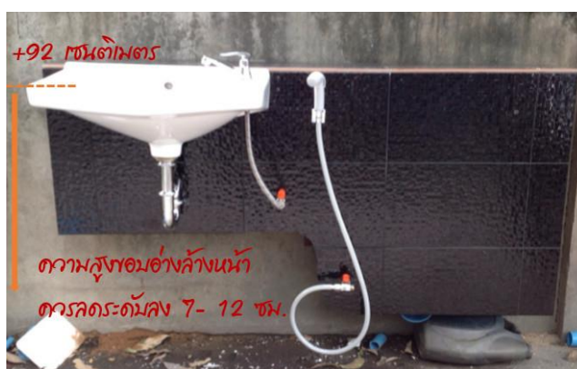
ภาพที่ 3.16 ระดับความสูงของอ่างล้างหน้า เมื่อทำการติดตั้งแล้วเสร็จ
