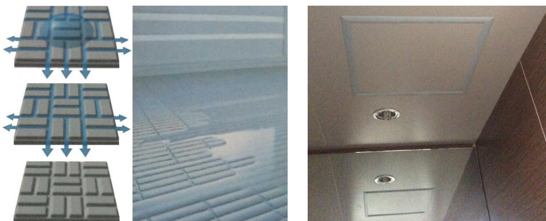
ภาพที่ 2.33 (ซ้าย)การออกแบบพื้นผิวเพื่อช่วยในการระบายน้ำ (ขวา)รอยต่อของแผ่นฝ้าเพดานและแผ่นผนัง [27]
