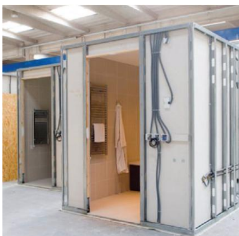
ภาพที่ 1.2 การเดินท่อสายไฟของห้องน้ำสำเร็จระบบ Bathroom Pods [3]
