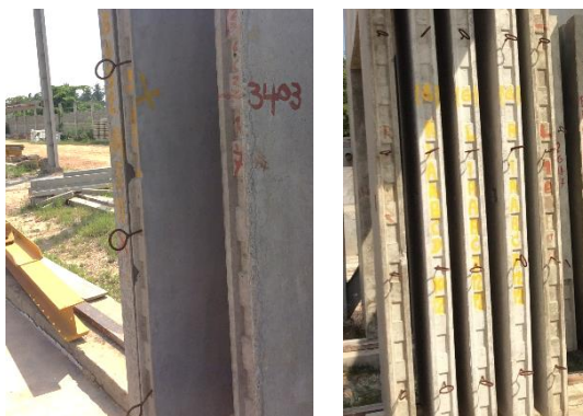
ภาพที่ 2.23 ระบบการฝังท่อเหล็ก [23]
