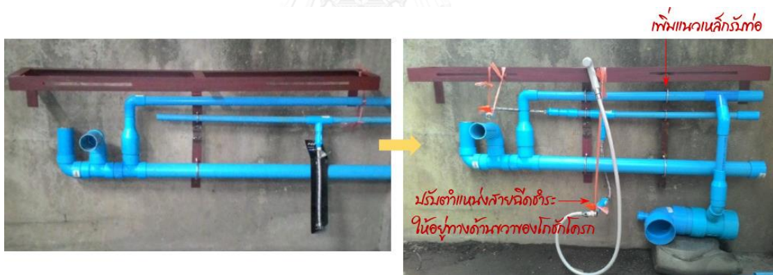
ภาพที่ 3.7 ปรับระยะตามความเหมาะสมจากการติดตั้งจริง
