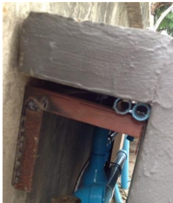
ภาพที่ 3.18 โครงเหล็กมีการแอนตัว เมื่อวางแผ่นผนังจึงเกิดความลาดเอียง
