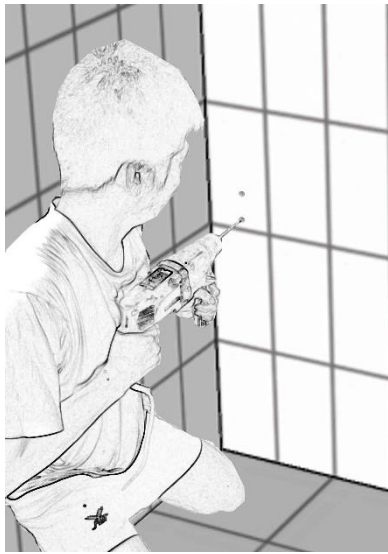
ภาพที่ 4.24 เจาะผนังด้วยส่วนเจาะคอนกรีตและตอกฝังพุกตะกั่วตัวเมีย
